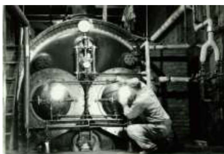
C棟西側に建てられていたボイラー室の内部の様子（建物は現存していない）
