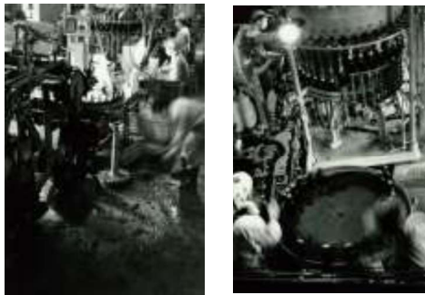
A棟2階・瓶詰機
