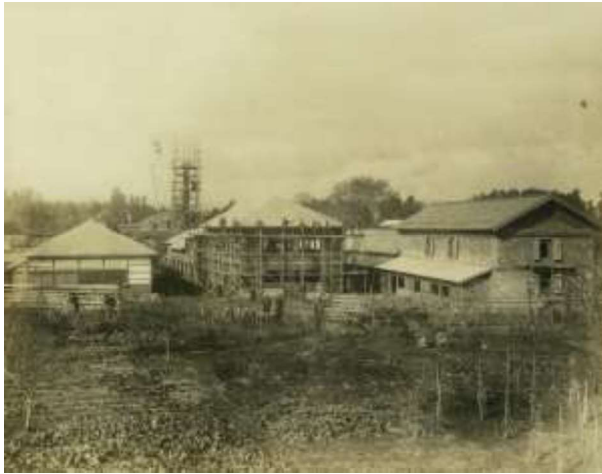
写真 i-6. 建設中の陸奥製糸会社 [撮影年：1919年（大正8年）/福嶋家蔵]
