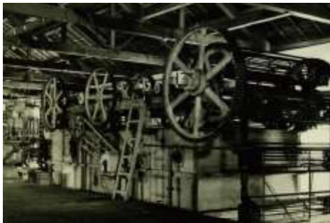
A棟2階・パストライザー (瓶詰されたシールドルを殺菌。上部にトラス構造の骨組が見える)
