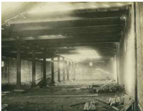
写真 i-8. 建築中の煉瓦倉庫内部 [1923年（大正12年）頃/福嶋家蔵]
