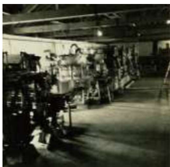
A棟2階・手前より瓶詰機、パストライザー、搾汁機
