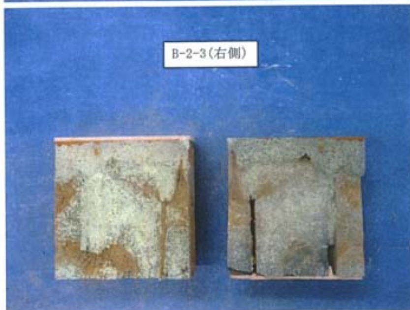
写真-95 目地モルタルの破壊状況 (写真-93 右側) [B-2-3]
