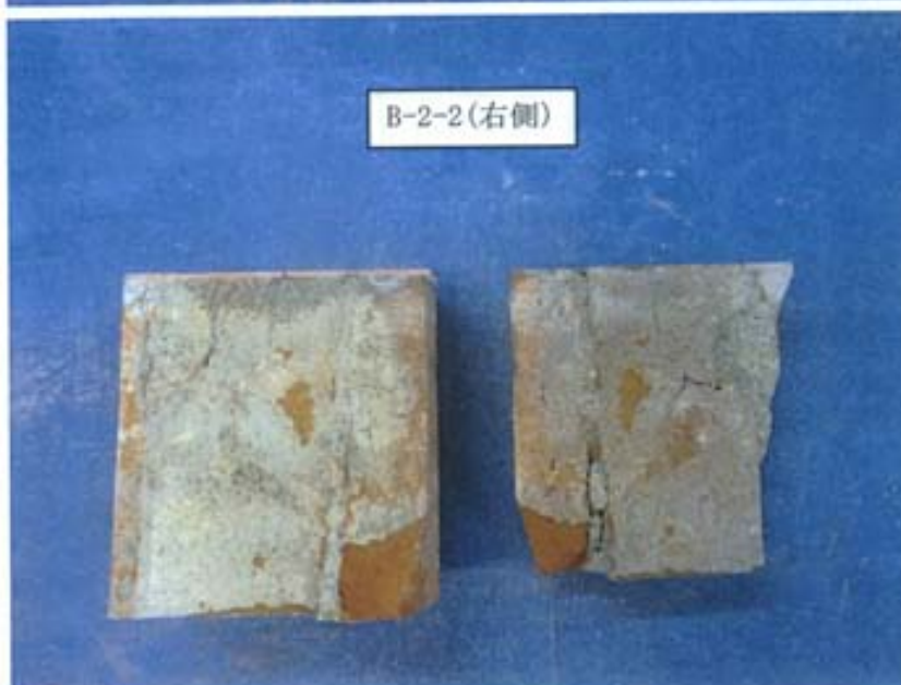
写真-92 目地モルタルの破壊状況 (写真-90 右側) [B-2-2]
