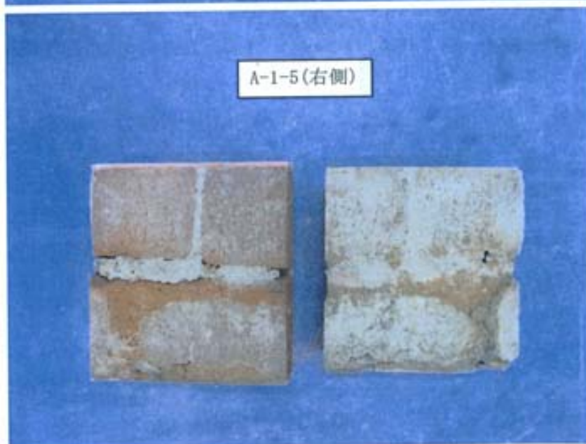
写真-62 目地モルタルの破壊状況 (写真-60 右側) [A-1-5]
