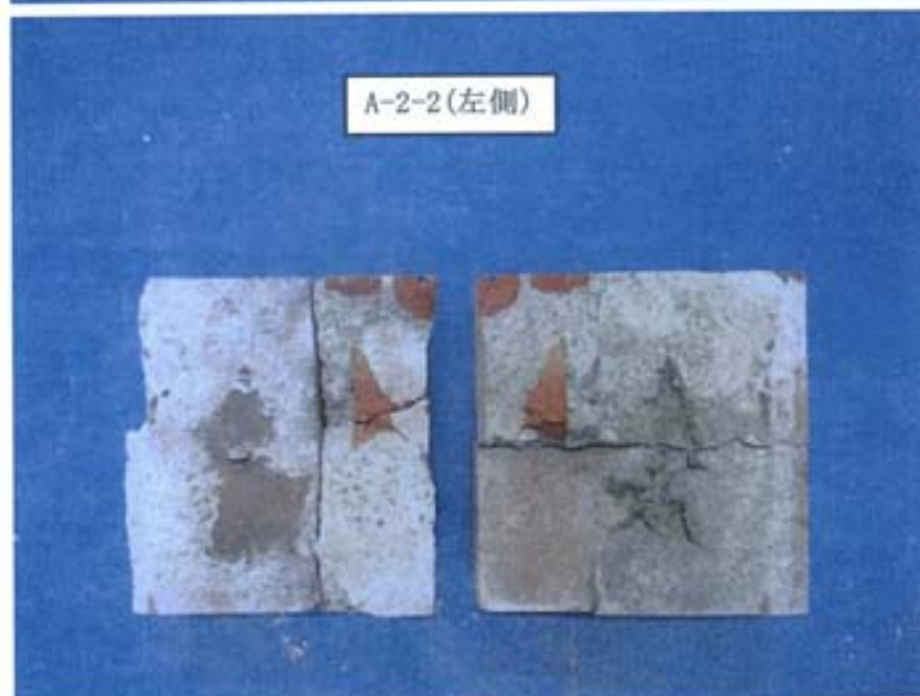
写真-67 目地モルタルの破壊状況 (写真-66 左側) [A-2-2]
