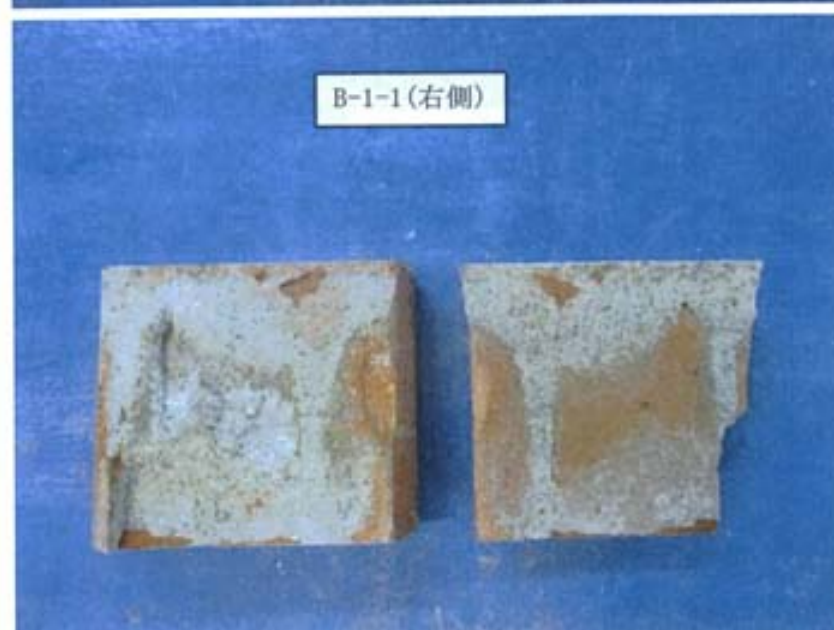
写真-74 目地モルタルの破壊状況 (写真-72 右側) [B-1-1]
