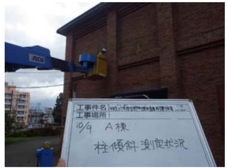
傾斜測定状況 (A棟高所作業車)
