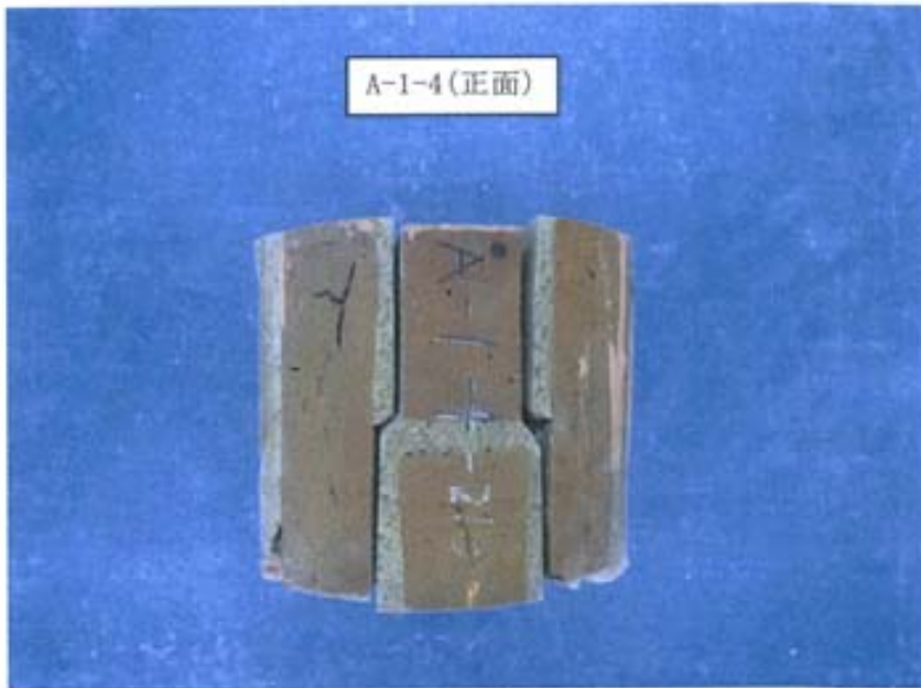
写真-57 目地モルタルの破壊状況 (正面)[A-1-4]
