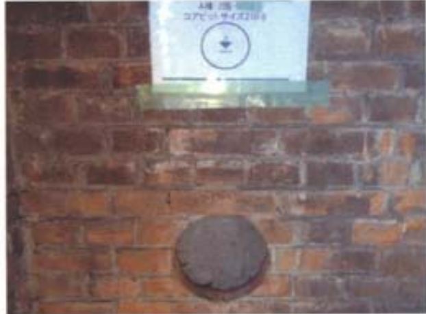
④削孔部穴埋め
