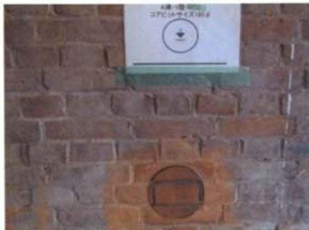
⑤補修完了
