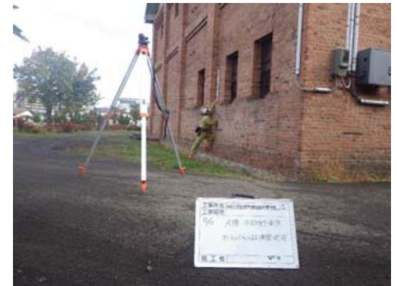
レベル測定状況写真(A棟)
