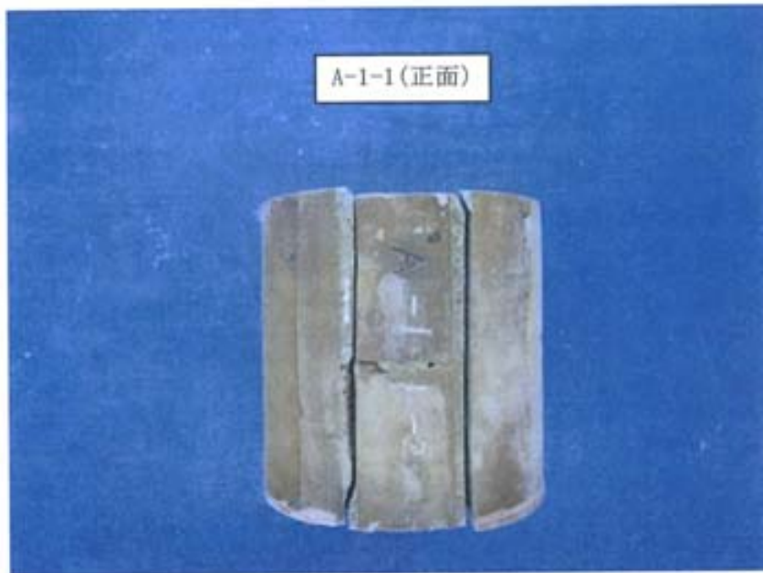
写真-48 目地モルタルの破壊状況 (正面) [A-1-1]
