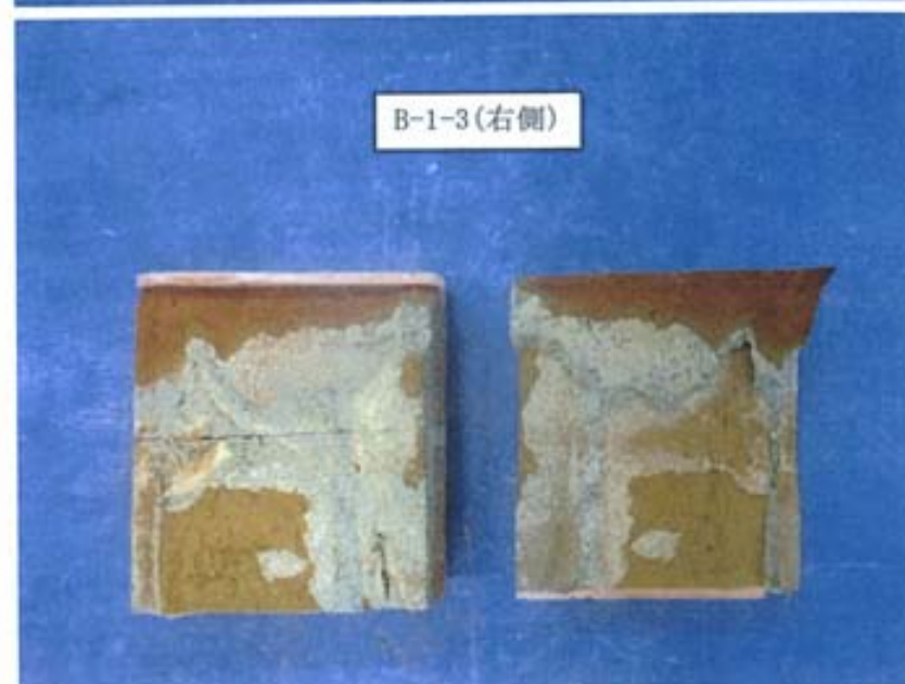
写真-80 目地モルタルの破壊状況 (写真-78 右側) [B-1-3]
