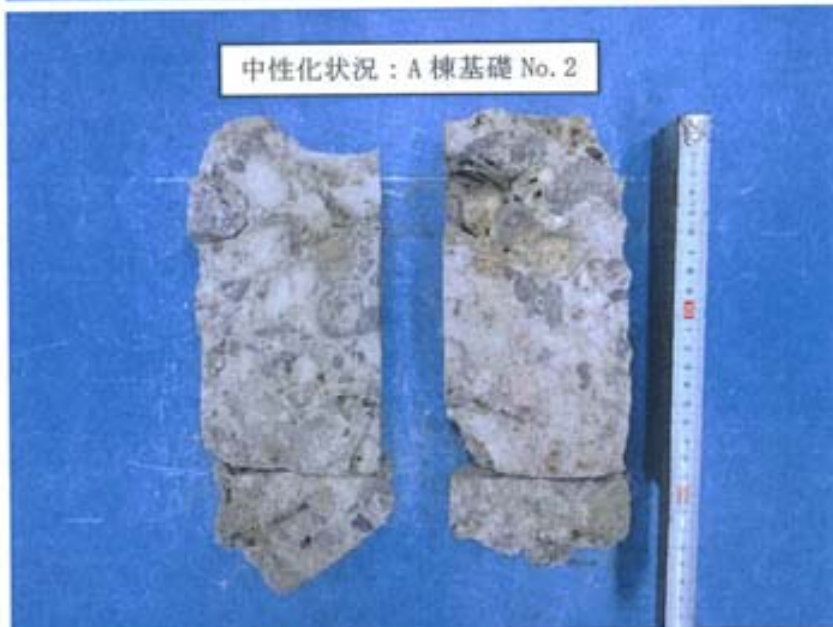
写真-5 中 性 化 状 況 [A棟基礎No. 2]
