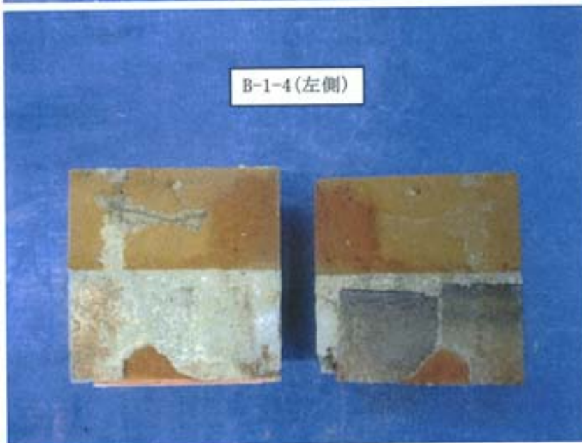
写真-82 目地モルタルの破壊状況 (写真-81 左側) [B-1-4]
