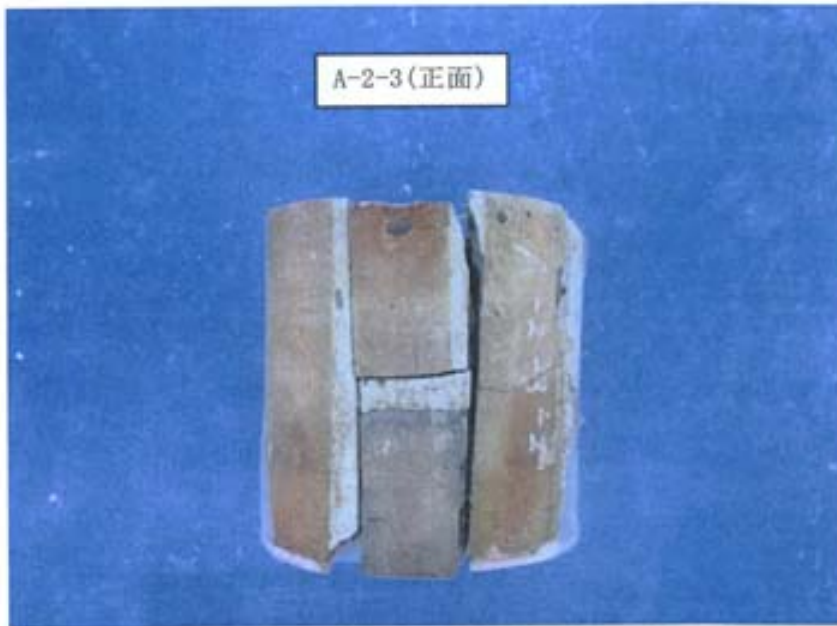
写真-69 目地モルタルの破壊状況 (正面) [A-2-3]
