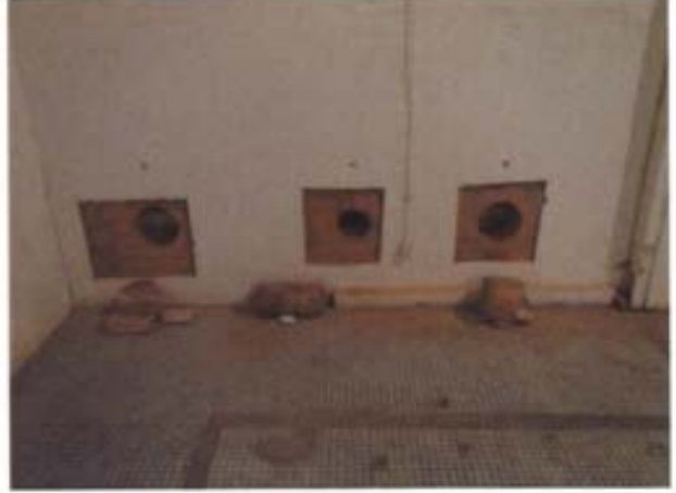
④削孔部穴埋め
