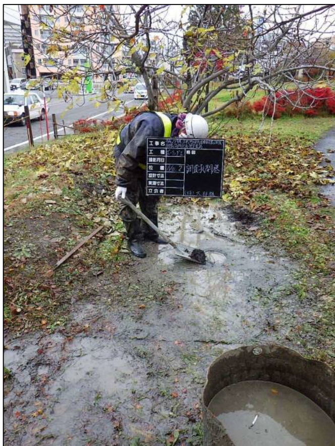
調査孔閉塞 (埋戻し)
