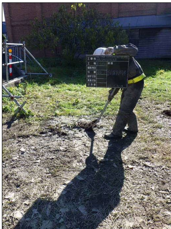
調査孔閉塞 (埋戻し)
