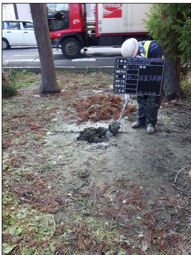
調査孔閉塞 (埋戻し)
