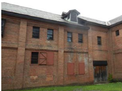
写真1 建物外観(南面)
