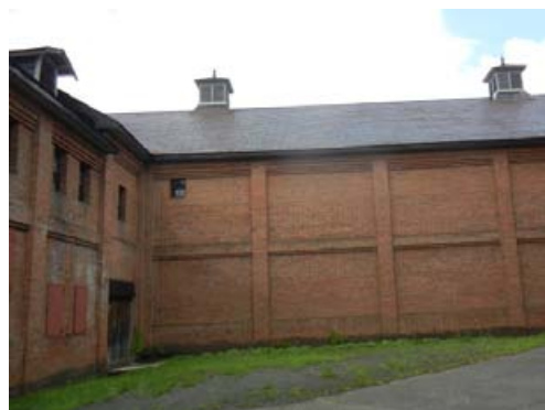
写真2 建物外観(西面)
