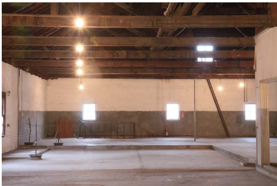
A棟 2階東側→西側
