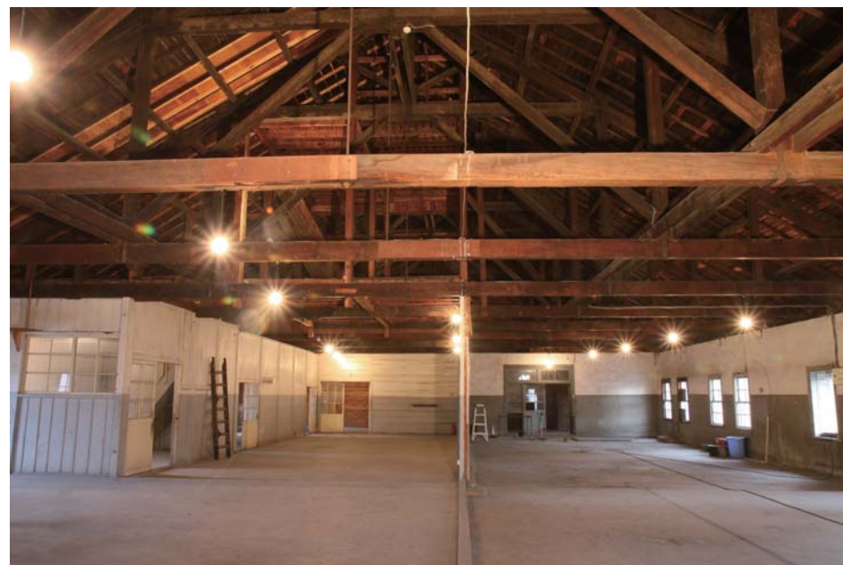
A棟 2階西側→東側
