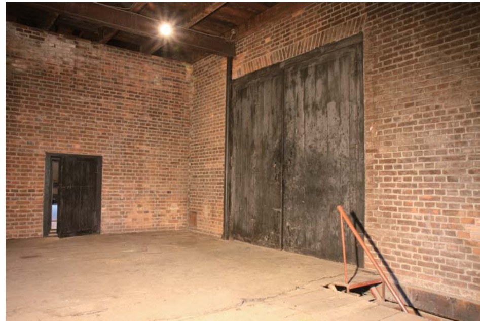
A棟 2階東側
