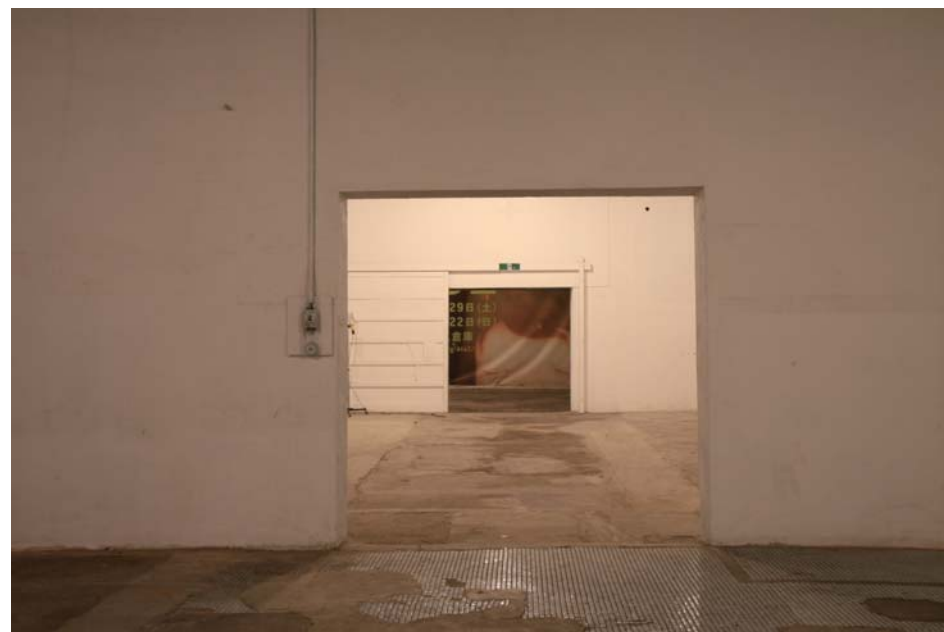
A棟 1階東側→西側
