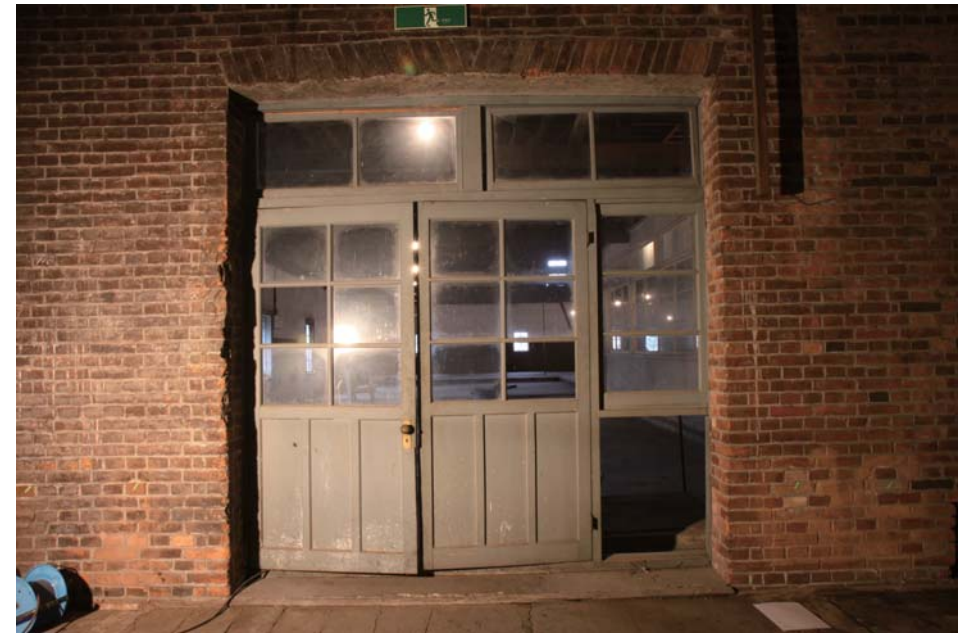
A棟 2階東側→西側
