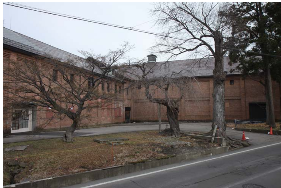
A・B棟南西面
