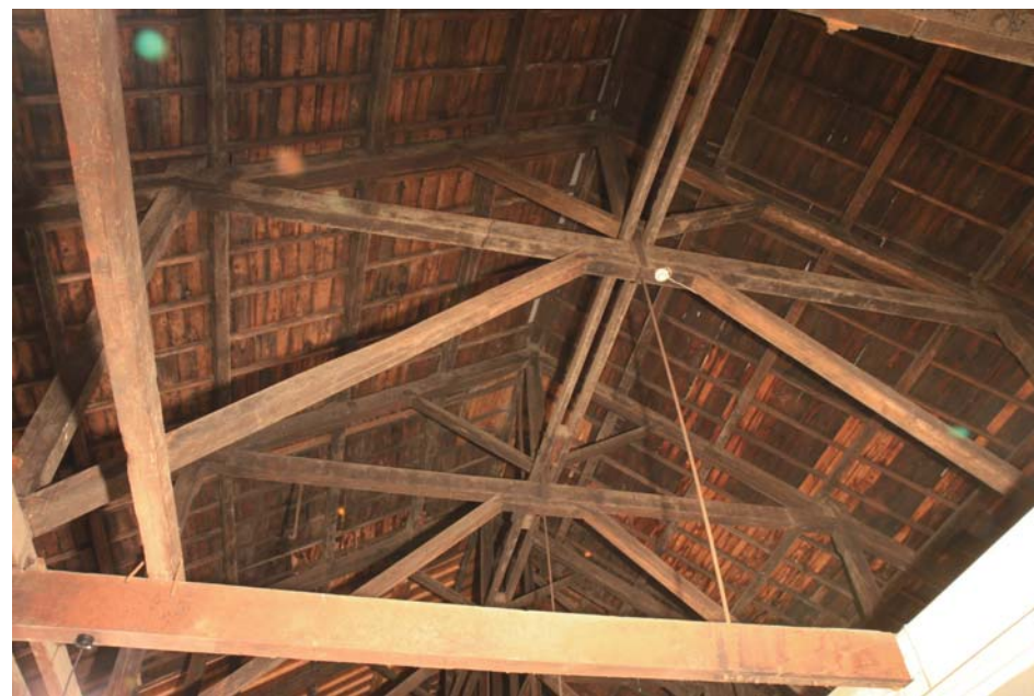
A棟 小屋組
