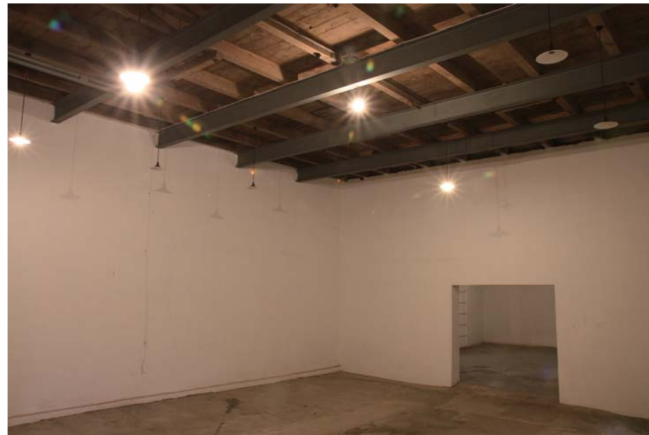
A棟 1階西側個室
