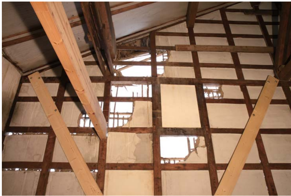
C棟 1階外壁
