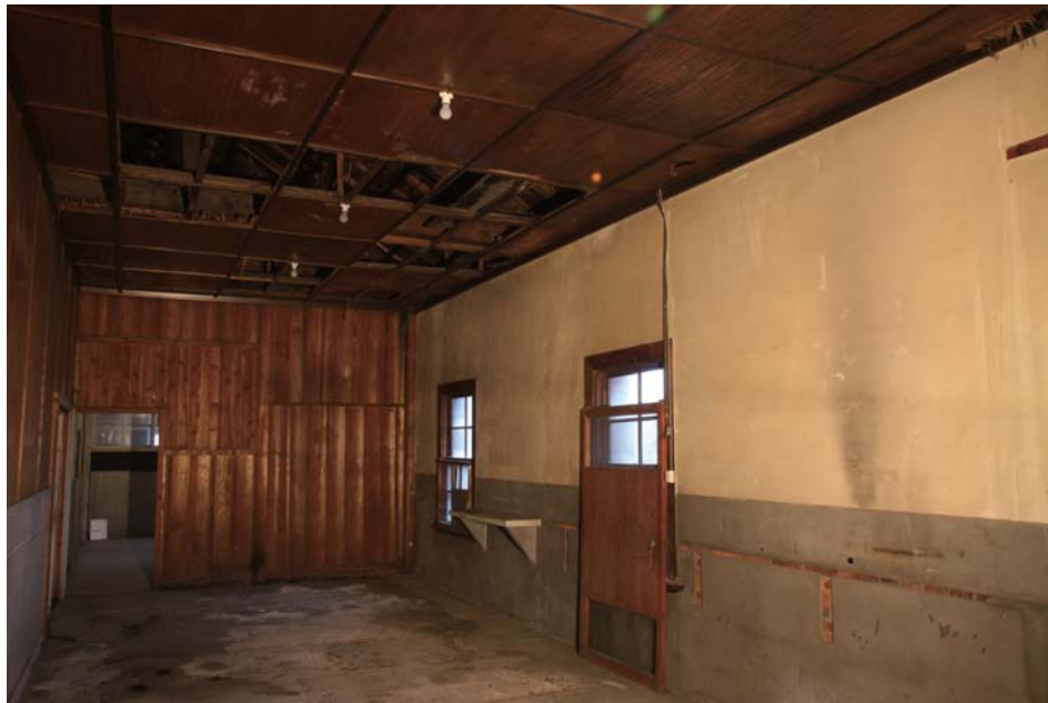
A棟 2階北側個室
