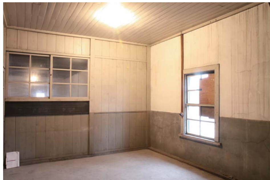
A棟 2階北側個室
