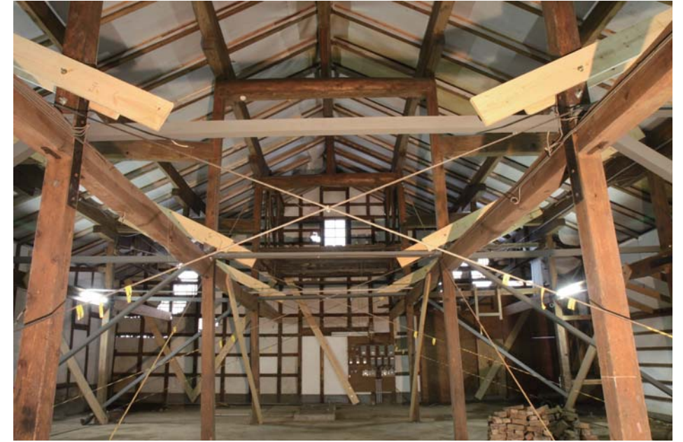
C棟 1階西側→東側
