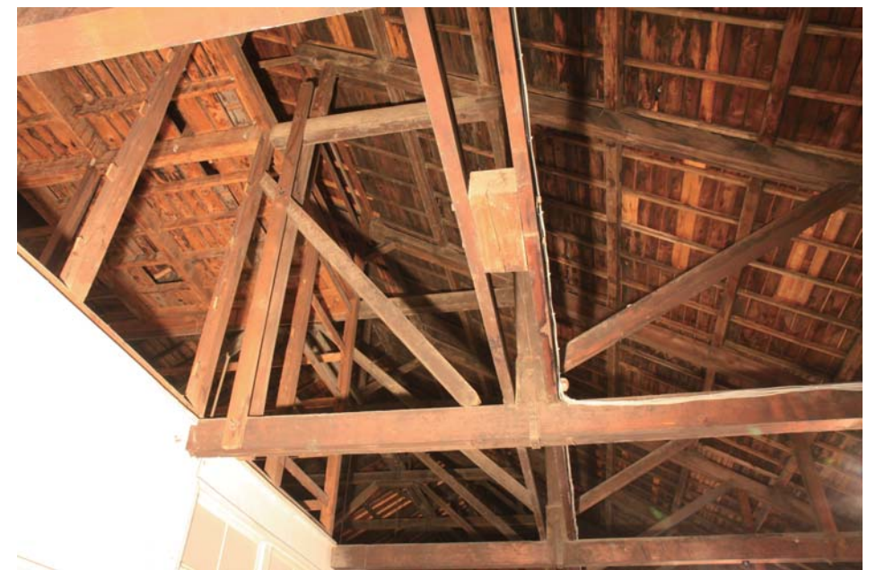
A棟 小屋組
