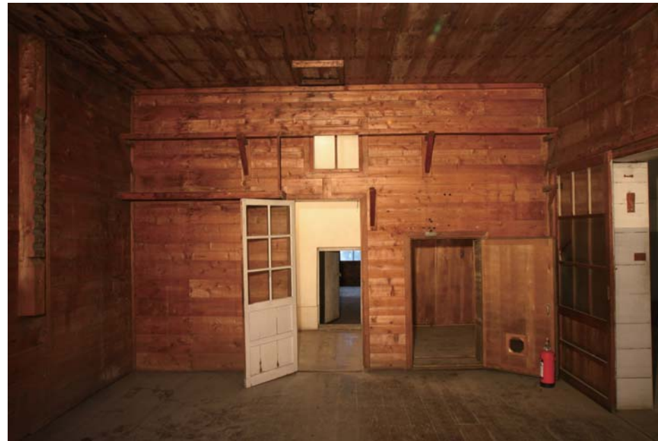
A棟 2階北側個室
