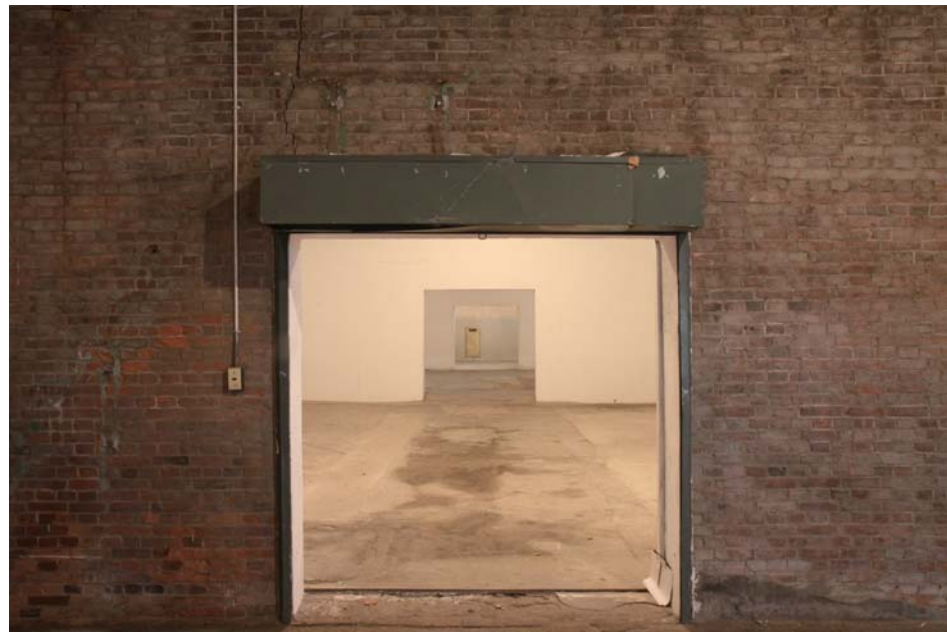
A棟 1階西側→東側
