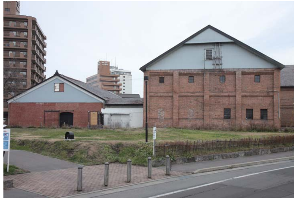
C・A棟西面
