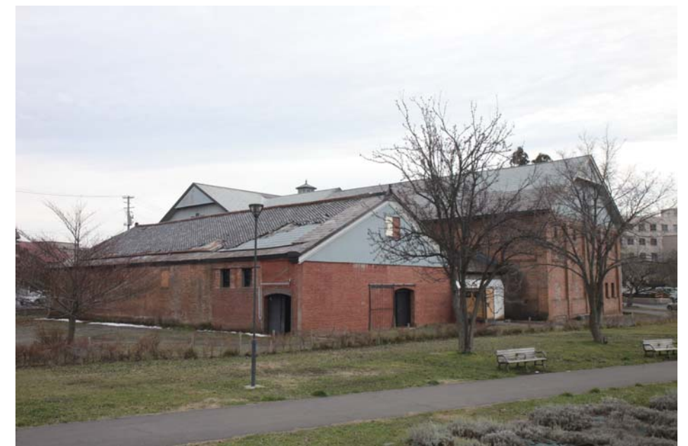
C・A棟北西面
