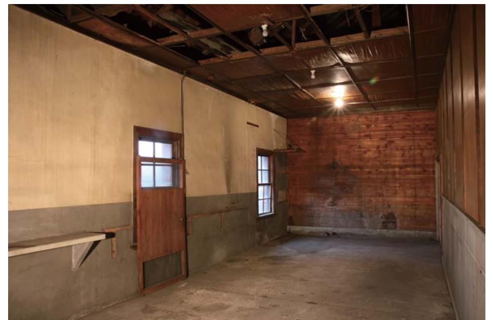
A棟 2階北側個室
