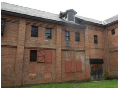
写真1 建物外観(南面)
