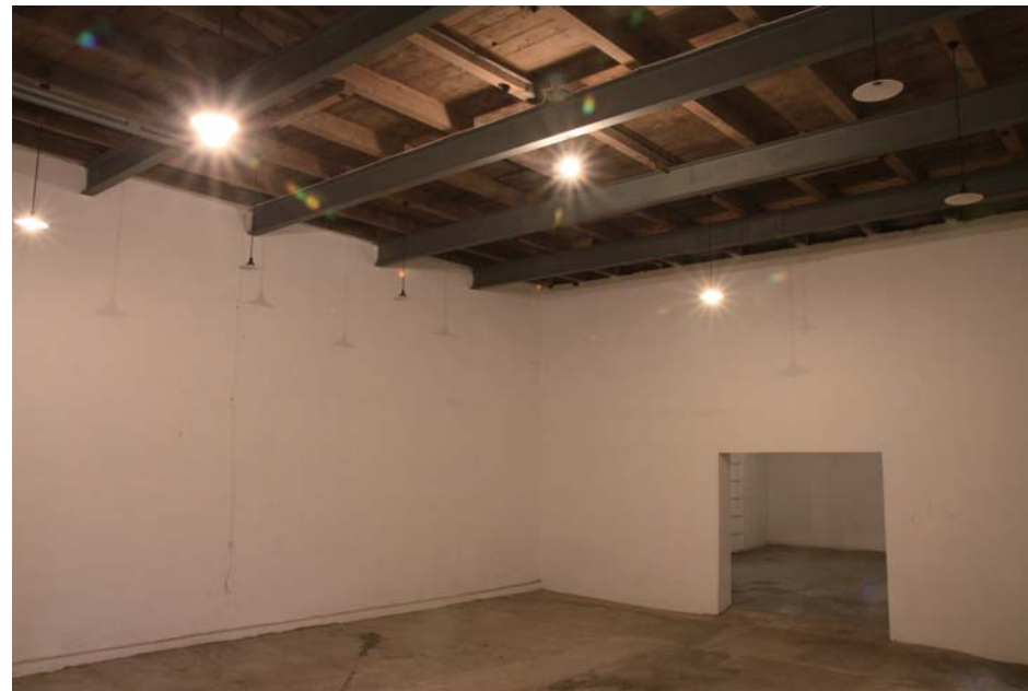
A棟 1階西側個室
