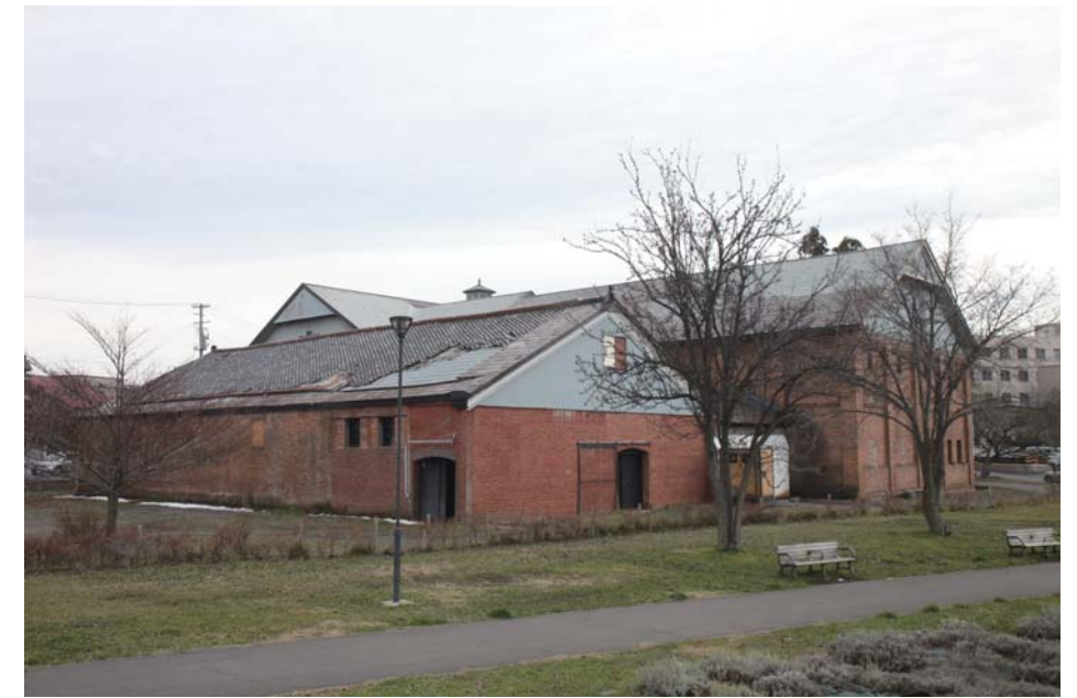
C・A棟北西面
