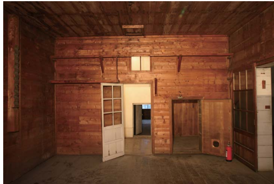
A棟 2階北側個室
