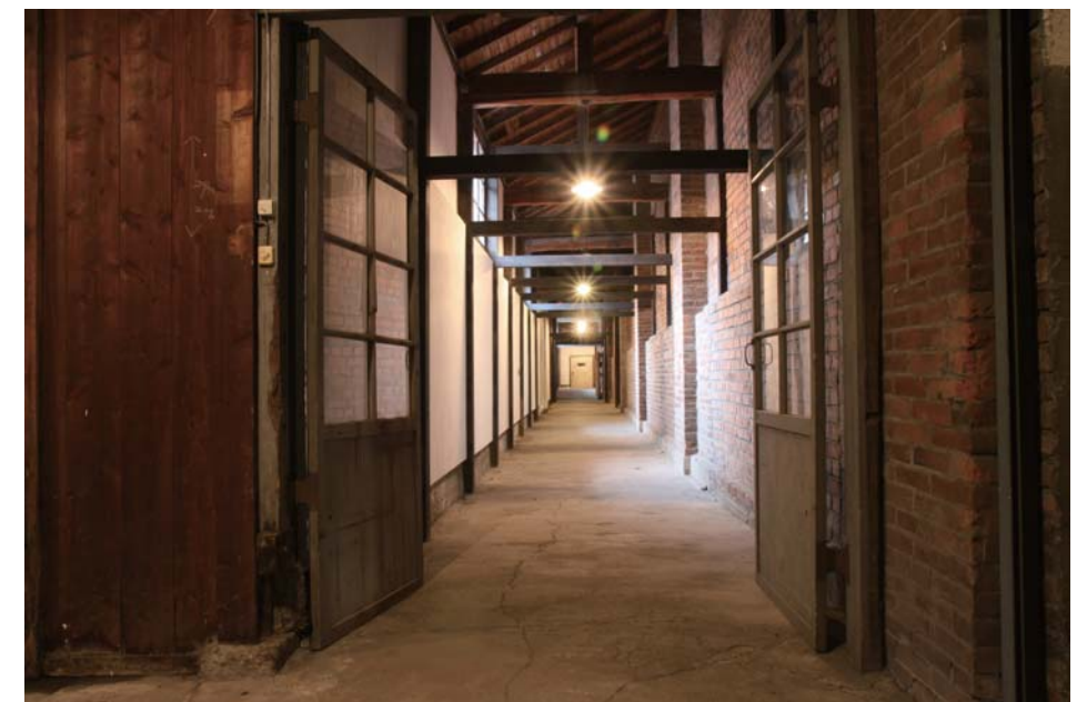
A棟横廊下 1階西側→東側 7-02
