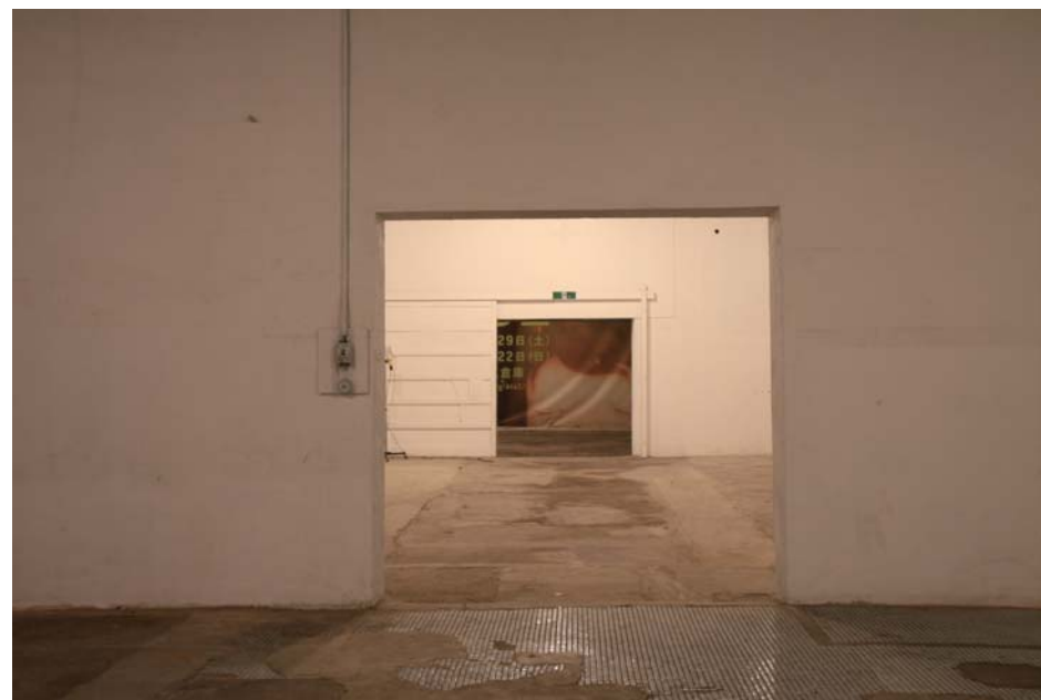
A棟 1階東側→西側
