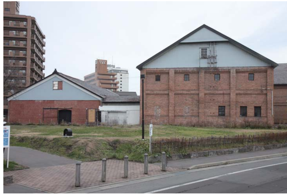
C・A棟西面
