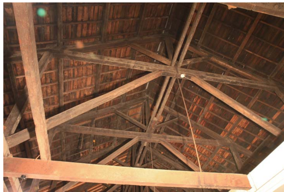
A棟 小屋組
