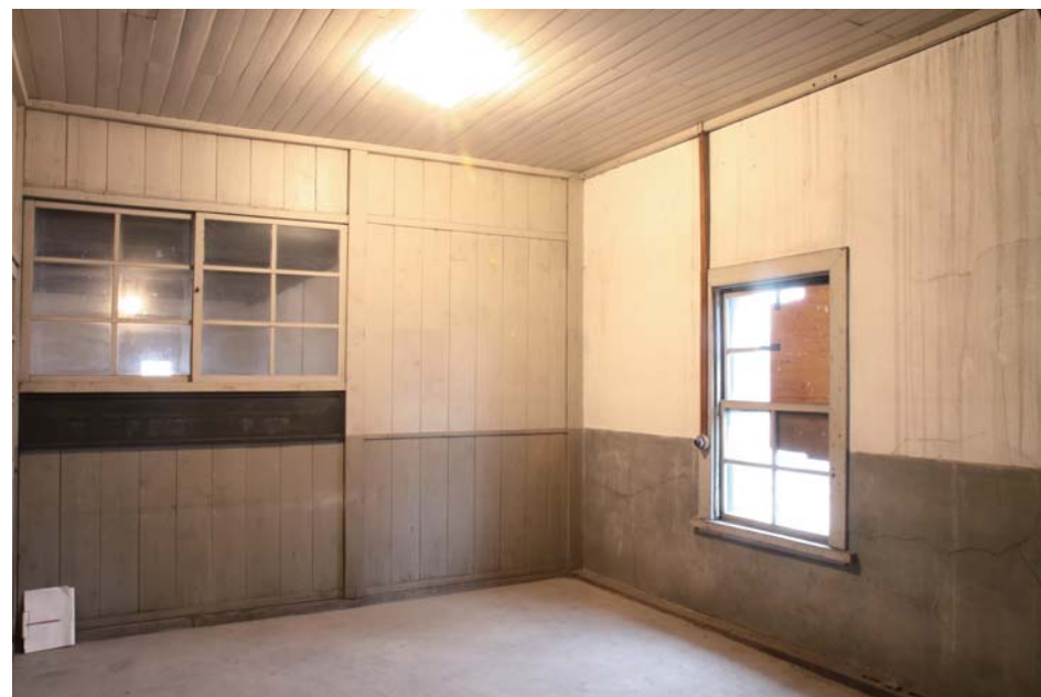
A棟 2階北側個室
