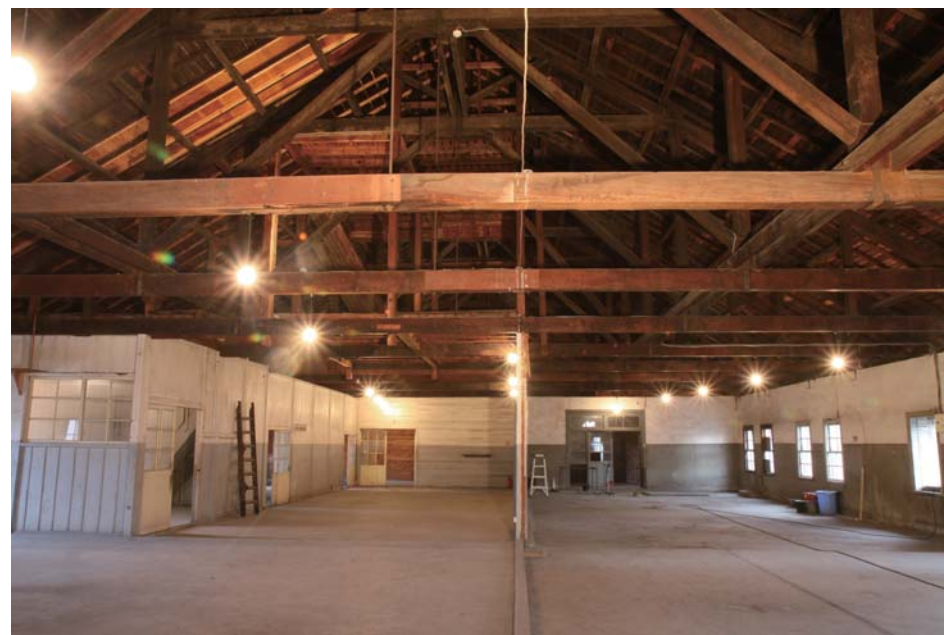
A棟 2階西側→東側
