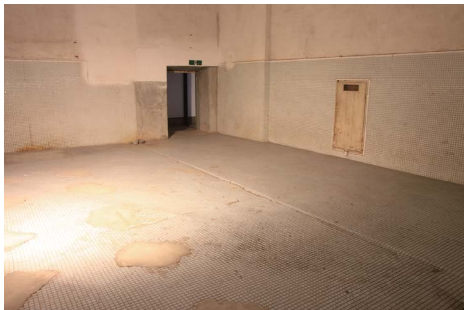
A棟 1階東側個室
