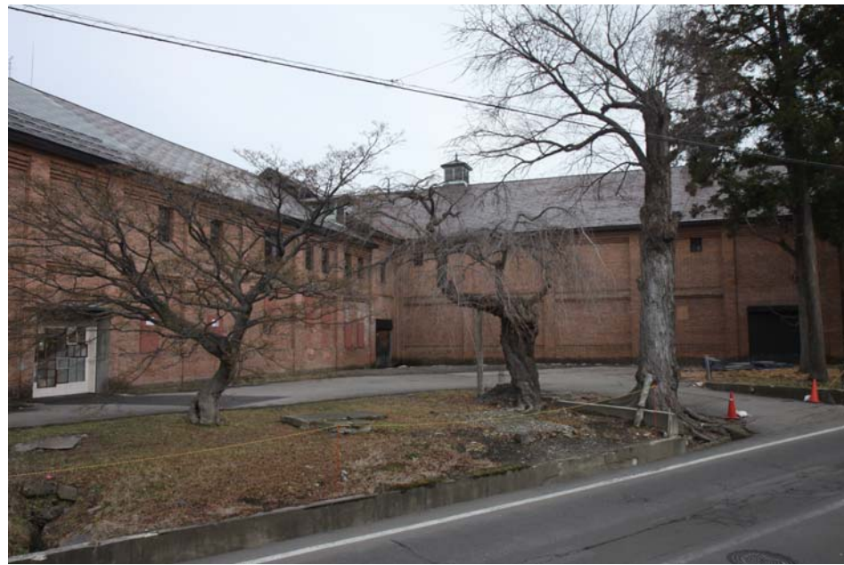
A・B棟南西面
