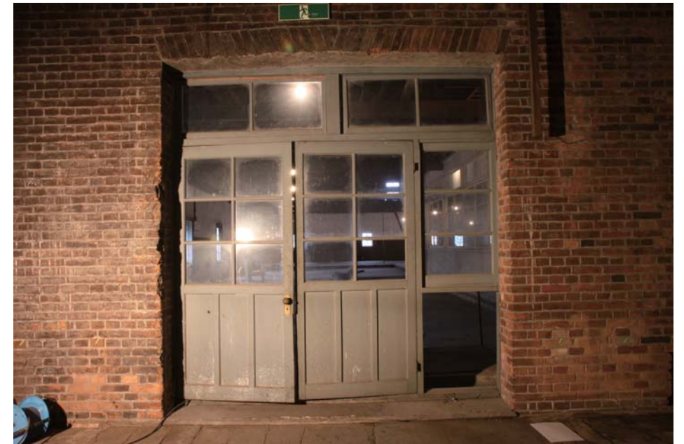
A棟 2階東側→西側
