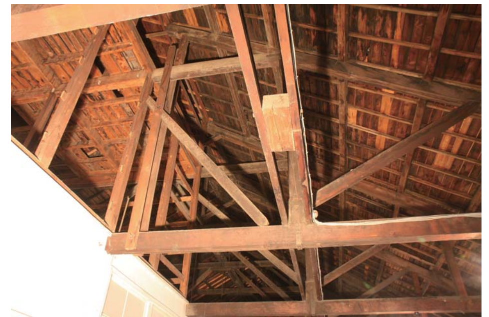
A棟 小屋組
