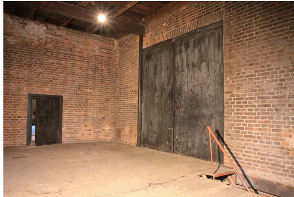
A棟 2階東側
