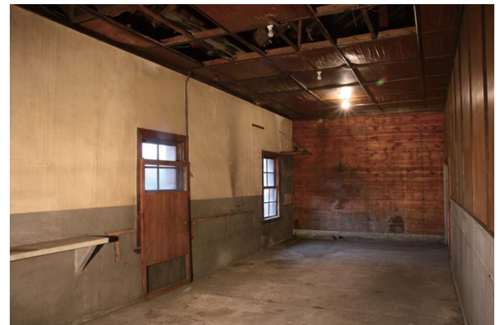
A棟 2階北側個室
