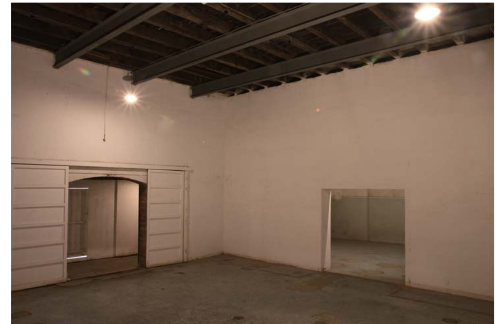
A棟 1階中央個室
