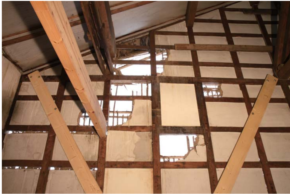
C棟 1階外壁
