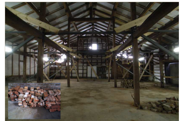
C棟 ・改修もしくは、解体を提案してよい。その際法定的に準耐火建築物（ロー1）とする事が求められる（資料8参照のこと）。
