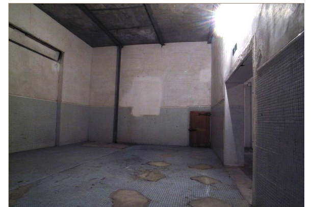
室4 ・モザイクタイル床の復旧など、既存インテリアをできるだけ復旧（あるいは再現）する。
