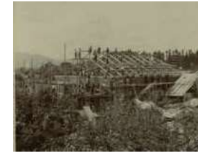
建設中の煉瓦倉庫の様子 福島家蔵
