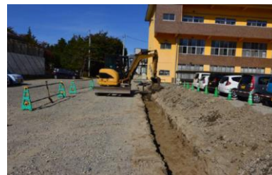
高圧受変電設備に係る電線管の埋設等を行った。
