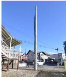
高圧受変電設備に係るコンクリート柱を設置した。
