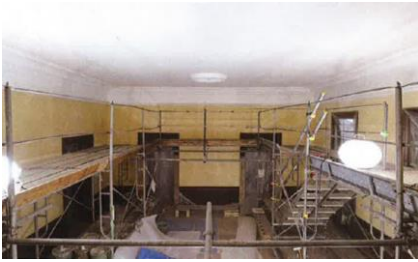
小集会所や控室等の壁の上塗りが完了した。
