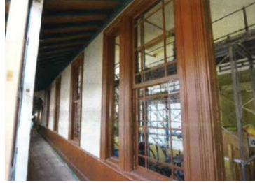
回転窓や引違窓、上下窓などの各建具及びクレセント等の金物の取り付けが概ね完了した。
