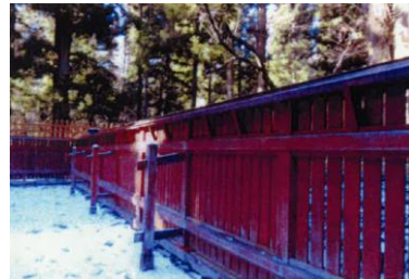
木製屋根を取り替えた。また、併せて補強工事を行った。 竣工：平成30年11月24日
