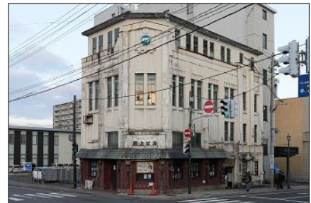
旧弘前無尽社屋(三上ビル)
