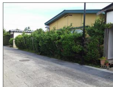
手入れがされていない生垣
