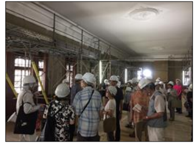
旧弘前偕行社修理現場公開
