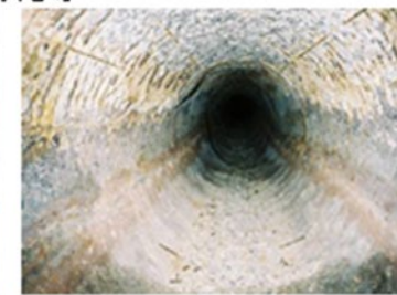
硫化水素による管路の腐食
