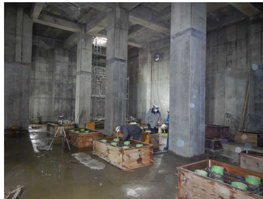
送水ポンプ棟内 機械基礎施工状況
