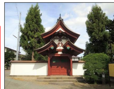
改修後の誓願寺山門
