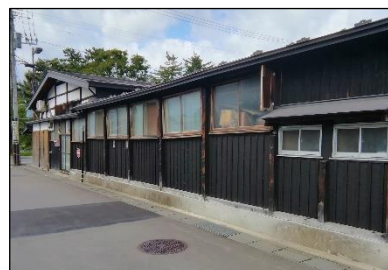
川崎染工場の外壁改修工事（R5）
