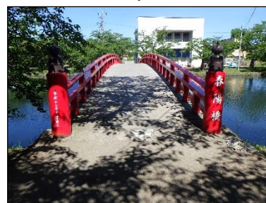
春陽橋の木部更新工事（R4）
