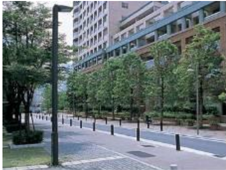
□地域の景観と一体となった舗装、ガードレール、街路樹等の整備 (オーバルコート大崎、東京都品川区)
