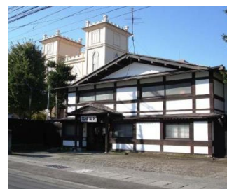
明治期の洋風建築；日本基督教団弘前教会教会堂（奥）と和風建築；石場旅館（手前）
