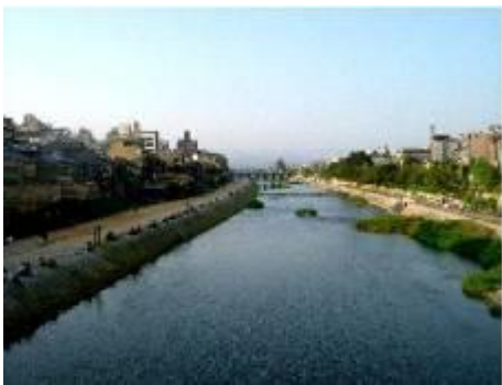
□地域の景観の骨格として、自然景観に調和した河川整備 (鴨川、京都府京都市)
