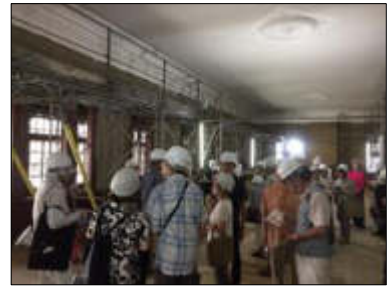
旧弘前偕行社修理現場公開
