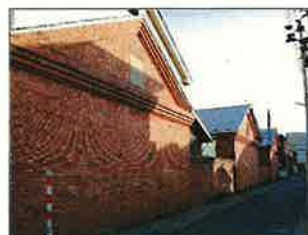
弘前銘醸煉瓦倉庫
