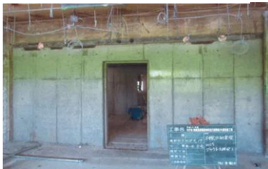
【耐震壁コンクリート打設完了】
