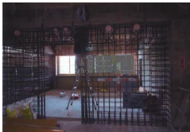
【耐震壁配筋状況】
