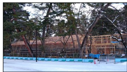
【利活用施設新築工事】
