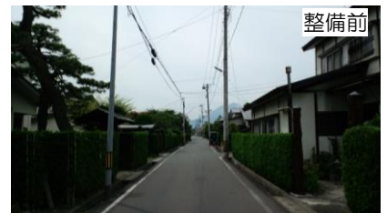
【消融雪溝整備状況写真】
