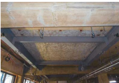
【炭素繊維シートによる補強完了】
