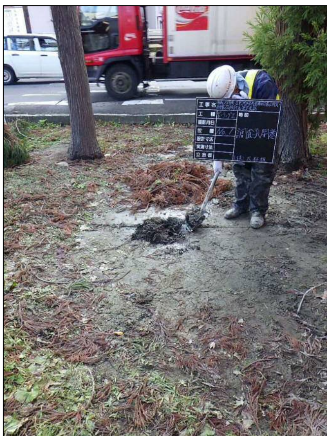
調査孔閉塞 (埋戻し)
