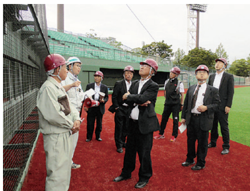
6月23日 はるか夢球場工事状況見学会
