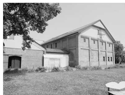
吉野町緑地煉瓦倉庫
