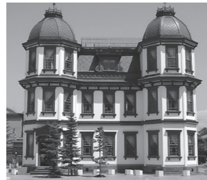
市民中央広場に移設することになった 旧弘前市立図書館
