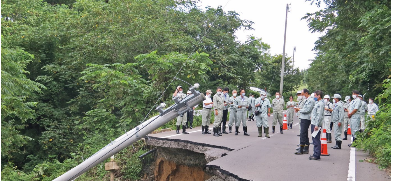
弘前市議会は8月25日、8月の大雨で大きな被害を受けた市内2道路(市道五代・高館線、津軽中部広域農道)を視察し、担当課から被害状況等についての説明を受け、意見交換・情報収集を行いました。この写真は、津軽中部広域農道での視察の様子です。
