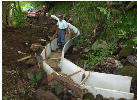
掘削し、U字溝を設置していきます。
