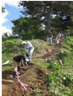
急な斜面に階段を設置していく作業
