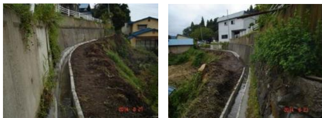
斜面での危険な作業でしたが、無事に完了しました。
