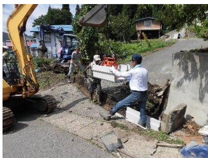
U字溝を設置していきます
