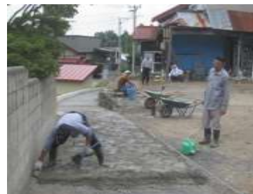
乳井の歴史的な場所を結ぶ小道の舗装
