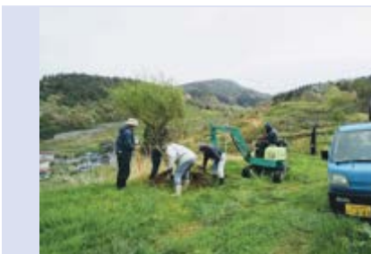
整備作業の様子
