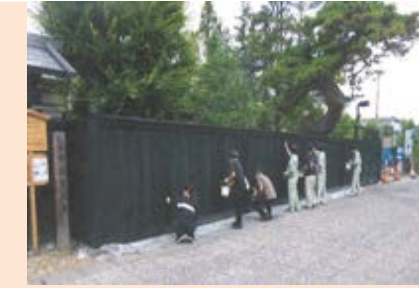
黒板塀・黒門柿波塗装実技体験会の様子
