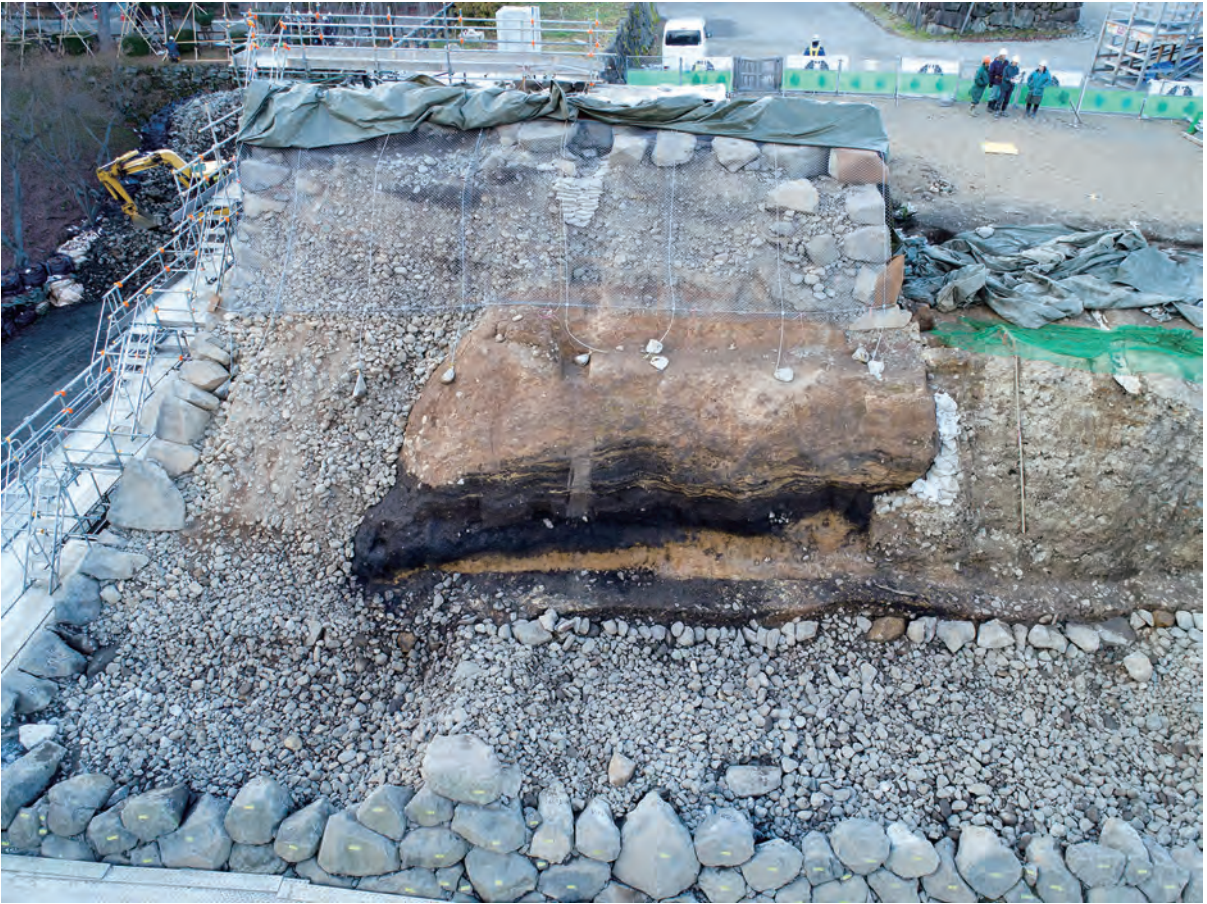
天守台石垣解体状況（平成29年11月29日撮影）東から
