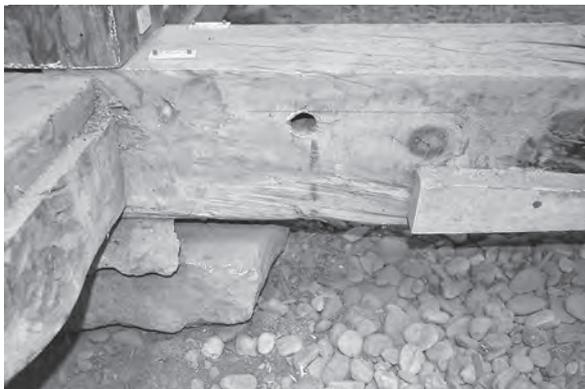
図版 20 天守土台角材の側面に入る貫通穴
