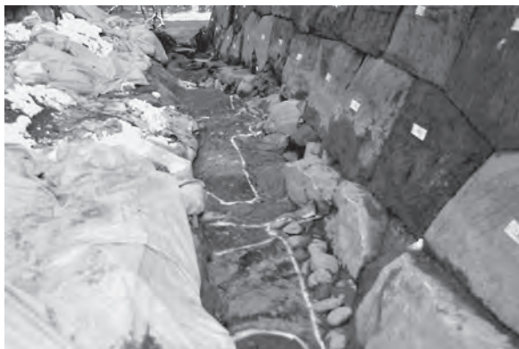
③天守台石垣北側基礎部（西から）
