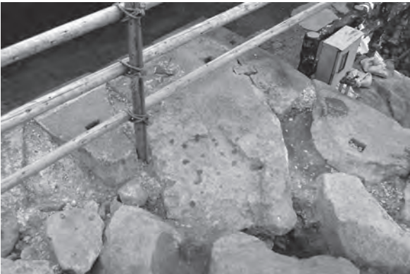
⑤天守台南西隅天端 イカ形の角石 （北東から）
