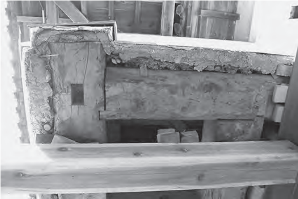
③天守土台下面のダボ穴（隅角部）
