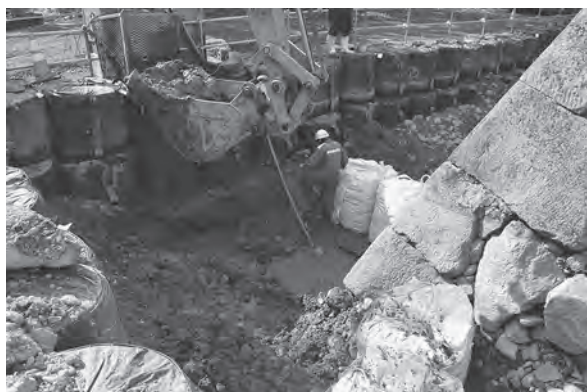
③Aトレンチ掘削作業風景(北東から)
