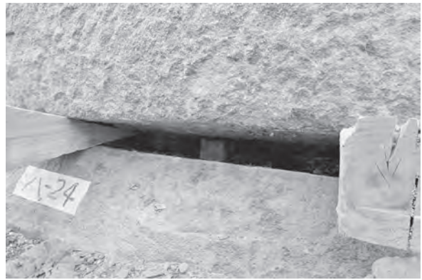
②天守台西側天端石と「ハ-24」をつなぐ鉛製ダボ（西から）
