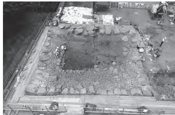
②天守台3石目上面検出状況(7月6日撮影)東から
