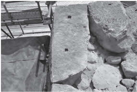
イ三角-4 上面ダボ穴 天守台石垣西側背面に残る構造(東から)
