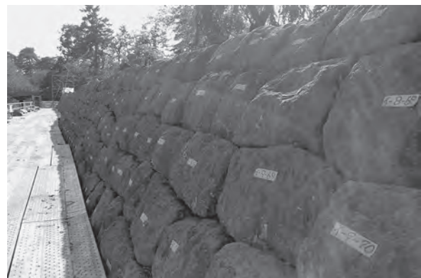
②近代(V-a期)の階段状石積み(北から)
