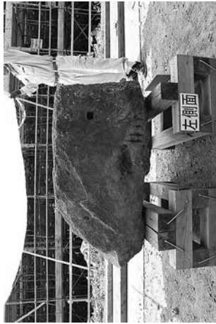
イ-1-11 左側面に横方向のダボ穴。 平面形 4 × 4 cm、深さ 6 cm。天端石の加工あり。
