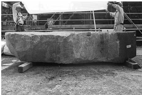
①天守台天端南東角石イ口角-1左側面
