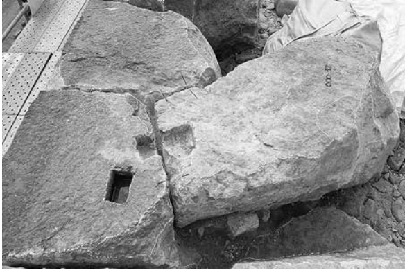
①イ-12と000-37(北から)鉄製チキリ取り外し後
