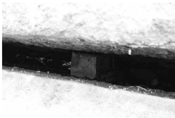
⑧ハ-24 上面鉛製ダボ(南西から)
