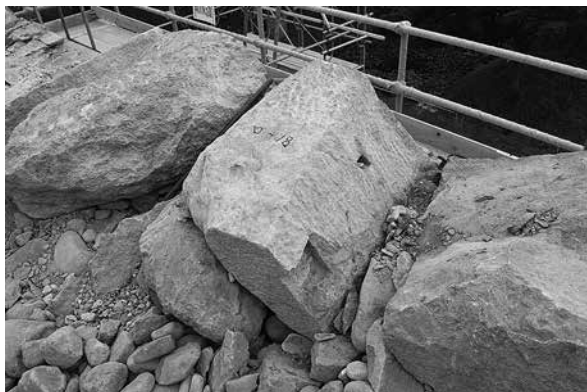
③ロ-18確認状況(北西)
