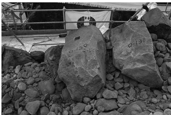
⑤ロ-130解体前(北から)
