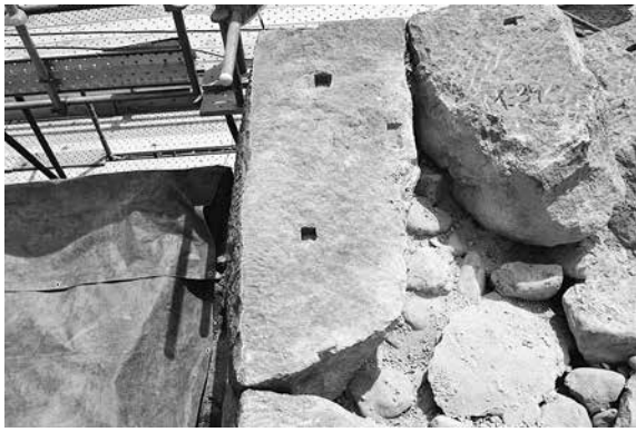
イ二角-4 上面ダボ穴 天守台石垣西側背面に残る構造 (東から)
