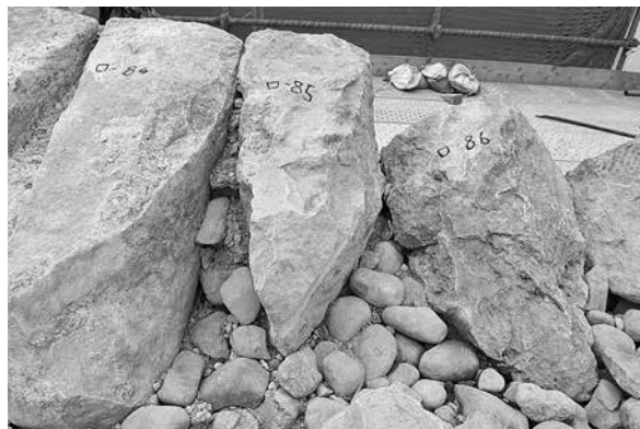
④ロ-85解体前(北から)
