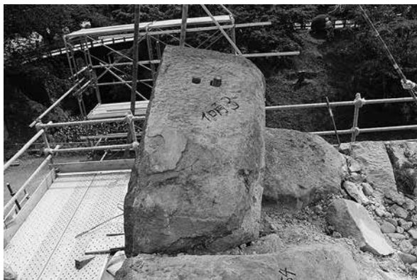
①イ口角-3 上面鉛製ダボ確認状況(北から)
