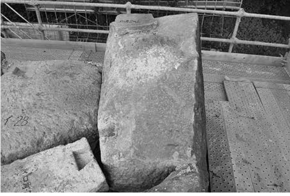
①イロ角-2と2' 解体前(西から)
