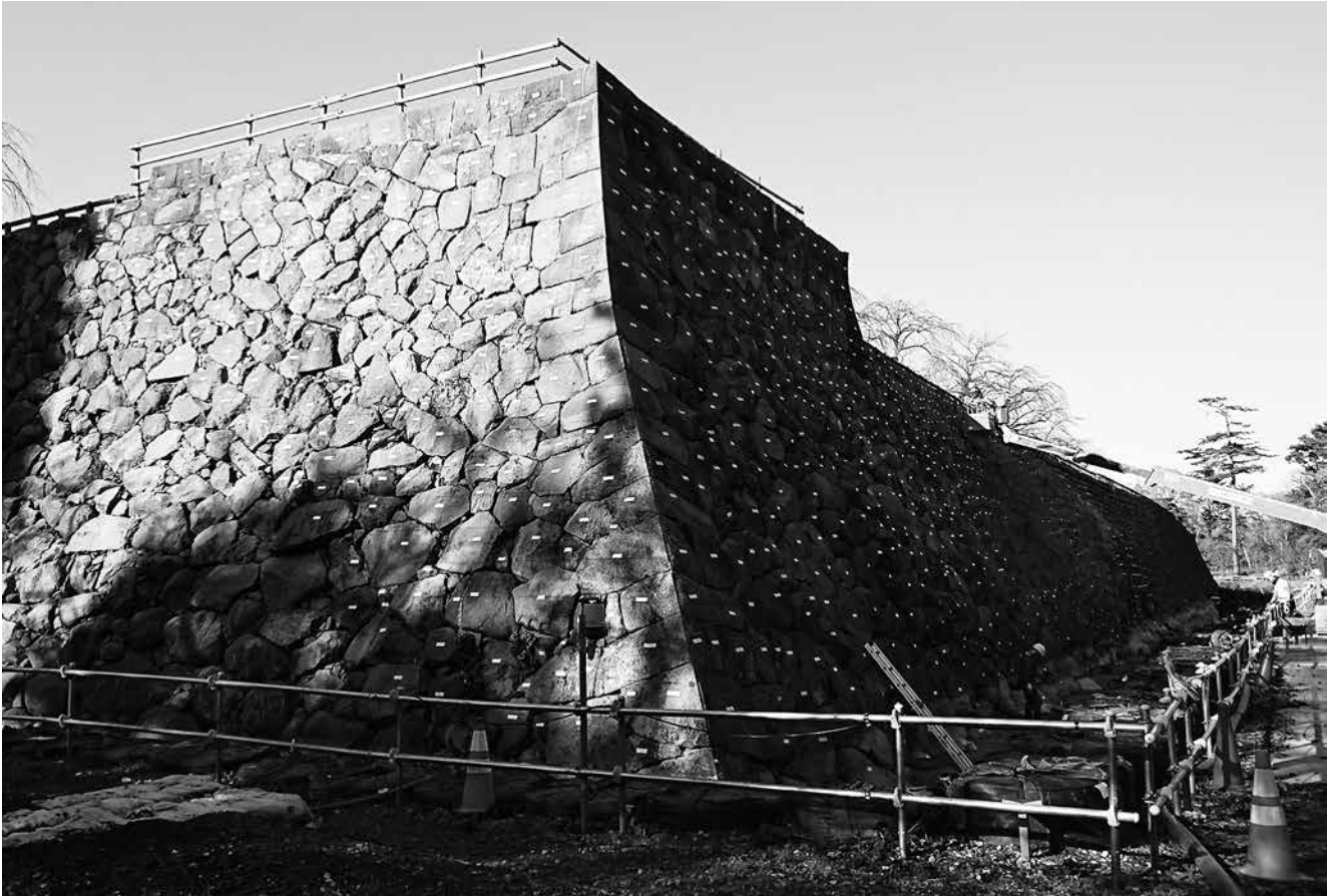
①石垣解体工事着手前(平成29年3月)南から
