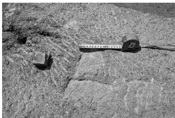
⑧口八角-1下面鉛製ダボ・矢穴・ノミ切り
