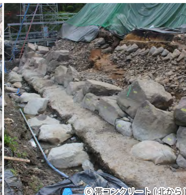
⑦ Eトレンチ(南から)
