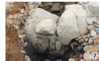
〔胴木と内濠石垣(写真⑦)〕 石垣の沈下を防ぐため、石垣下部に据える木材のことを「胴木」と言います。弘前城本丸石垣でも、発掘調査で胴木が確認されています。胴木は一辺24cm程度の角材で、樹種はヒノキ科アスナロ属とクリです。また、天守台東面下の内濠では、石垣の前面に巨石を用いた低い石垣(写真⑦)が確認されました。これは本丸南東隅の櫓台下の土台を補強するため、築城時に設けられたものと考えられます。
