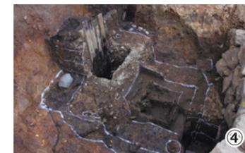
〔井戸跡(写真④)〕 井戸跡の掘方は直径約9mの楕円形をしており、東側に長さ約5m(4~8石)、高さ8m(11段)にわたる石組を伴っていました。東側の石組11段目付近の深さで、掘方中央部に二重の木製井戸枠が発見されました。木枠は正方形で、外側が一辺1.7mほど、内側が一辺1.2mほどです。外側の木枠と内側の木枠の間には砂が詰められており、壁から流入する泥水をろ過する働きがあったと考えられます。
