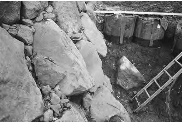
Bトレンチで検出した石積み（南から）
