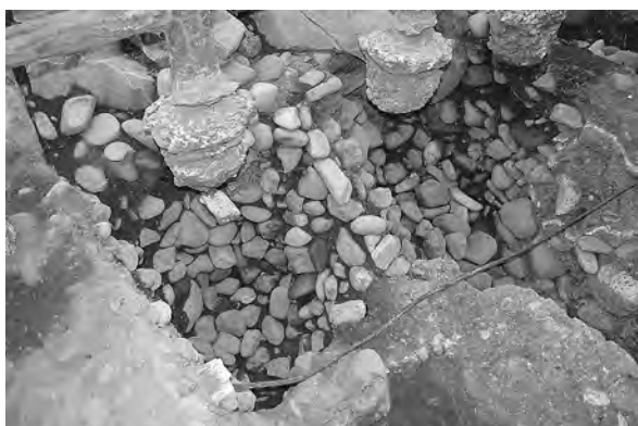
A16天端石・2石目背面に入る裏込全景 (北西から)
