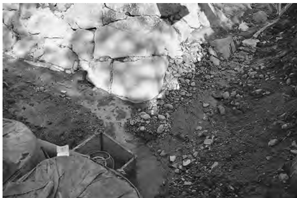
Aトレンチ掘削前状況（南東から）
