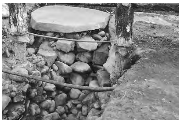
天端石下に続く礫層の堆積 (北西から)
