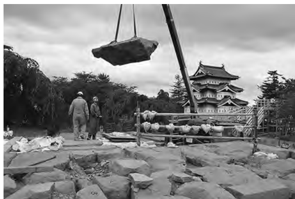
天守台上面石材取り上げ (南東から)
