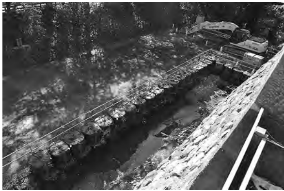
内濠排水工事（北西から）
