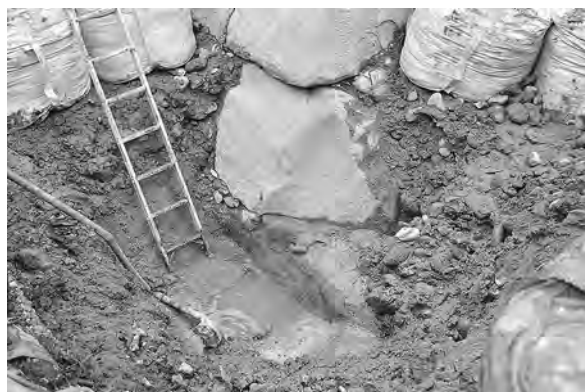
Aトレンチ根石下地山掘削状況（南東から）
