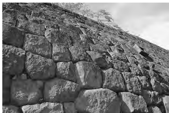
B トレンチから石垣上方を望む
