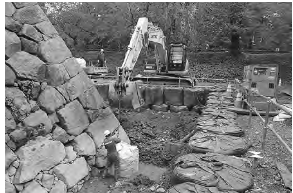
Aトレンチ掘削作業風景（西から）
