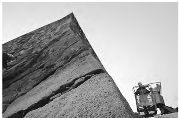
Aトレンチから天守台を望む
