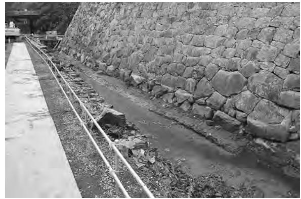
南端石垣沿いに帯コンクリート検出（北東から）
