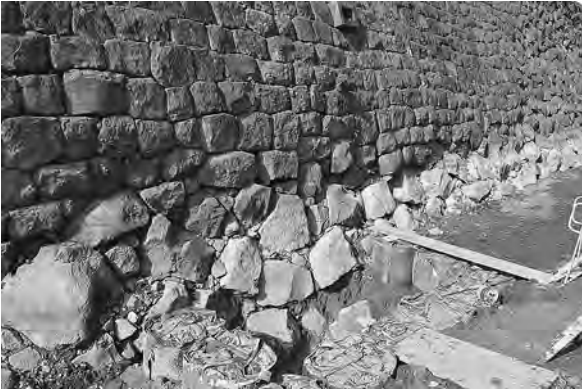
Bトレンチ近景（南東から）
