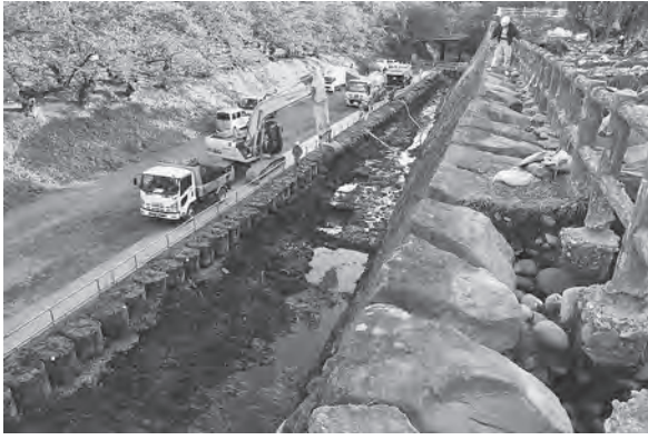
内濠浚渫工事状況（10月13日）
