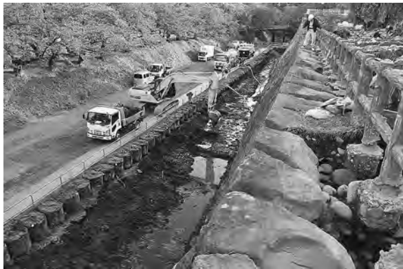
内濠浚渫工事状況（北西から）
