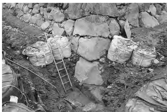
Aトレンチ全景（南東から）
