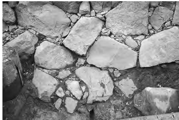
B トレンチで検出した石積み（東から）
