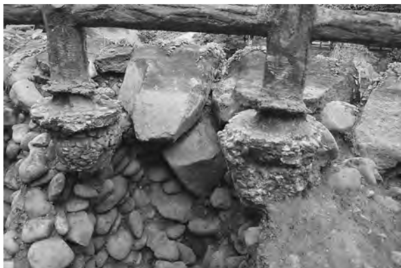
A16天端石・2石目確認状況（南西から）
