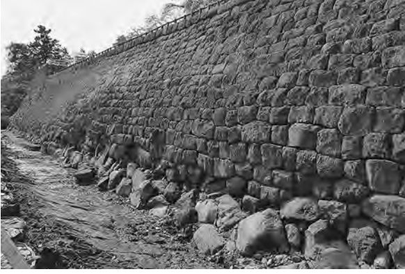
Bトレンチ掘削前状況（北東から）
