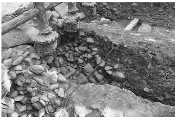
A16南側天端石・2石目背面に入る裏込断面（北西から）
