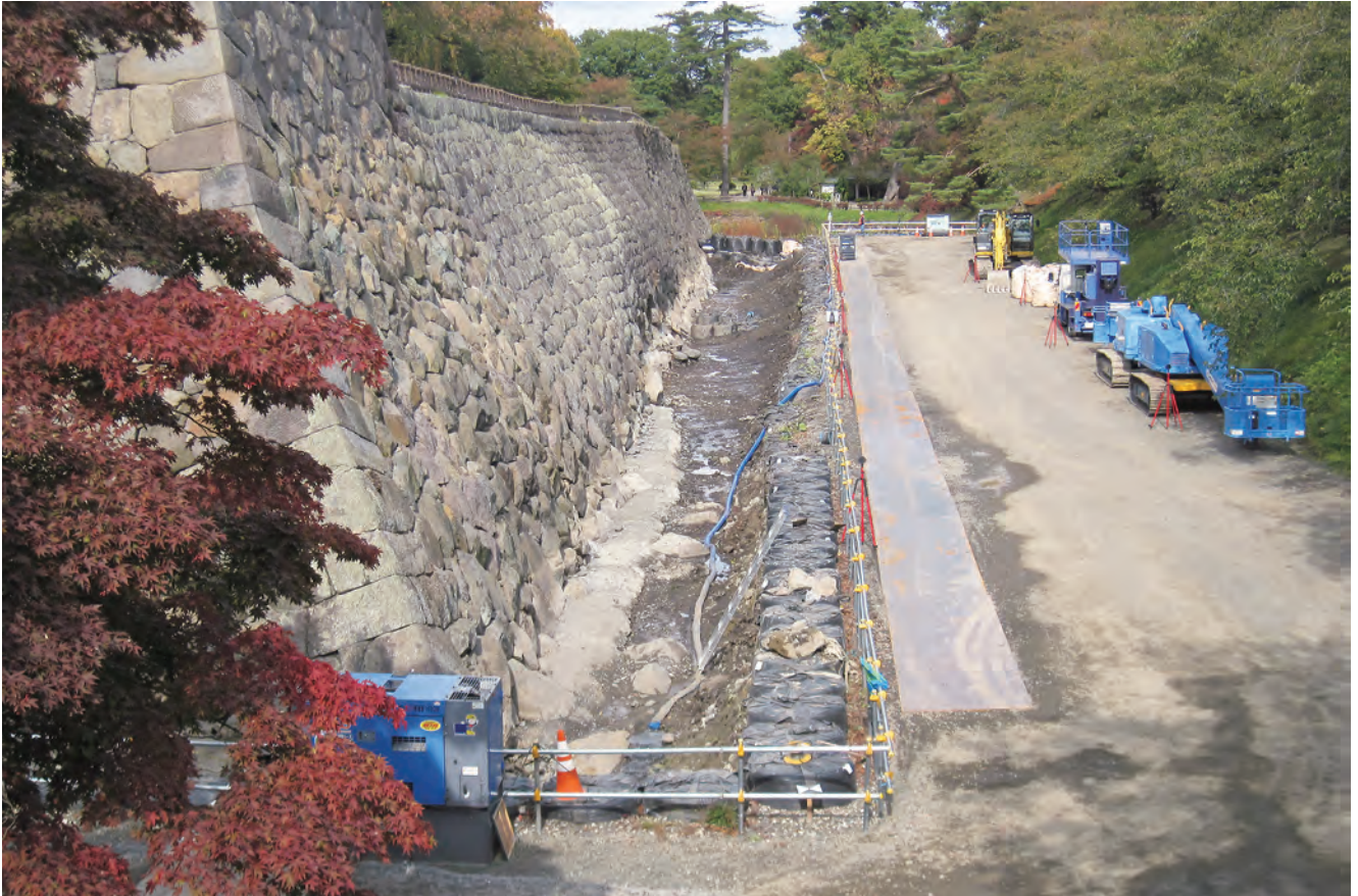
本丸東側石垣南端帯コンクリート全景（南から）
