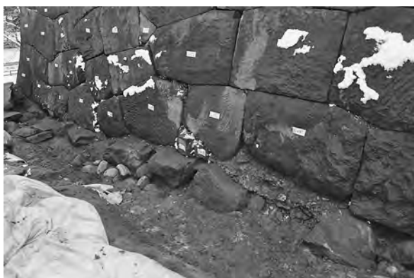
天守台北側石垣中央部根石列とモルタル (北西から)
