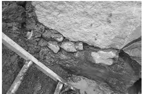
根石の下に入る小型石列（南から）
