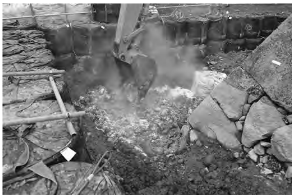
Aトレンチ埋め戻し状況（北東から）
