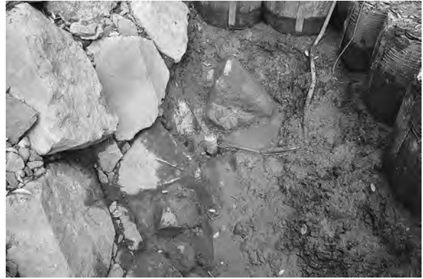
根石底辺検出（南から）
