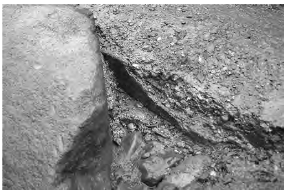
コンクリートの枠板（北東から）
