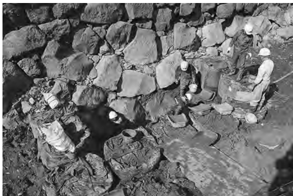
Bトレンチ作業風景（南東から）
