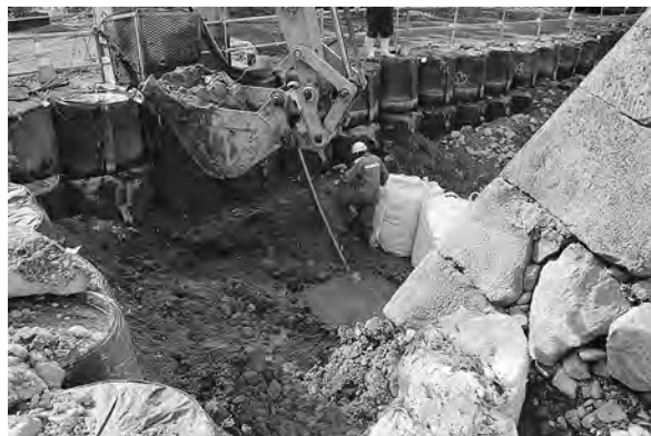
Aトレンチ掘削作業風景（北東から）
