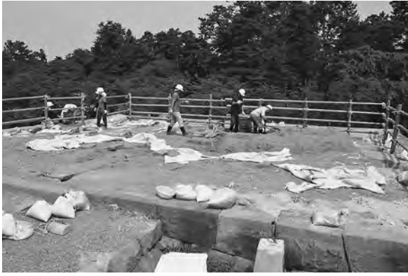
天守台養生砂除去作業開始（6月6日）
