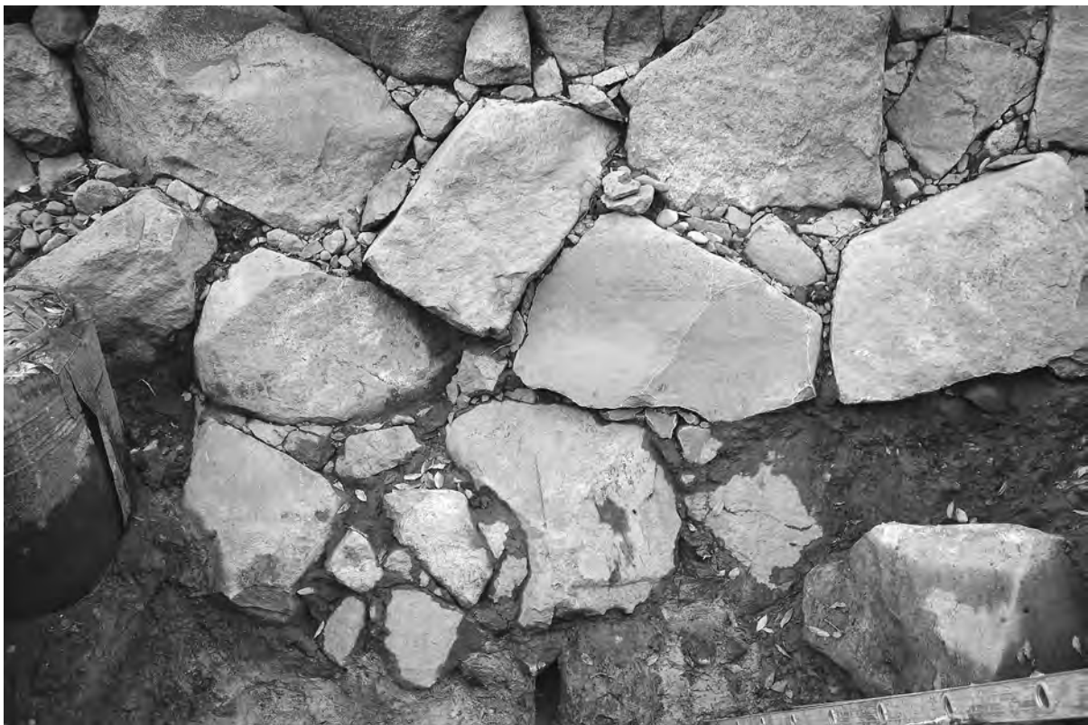
図版25 内濠Bトレンチ 根石付近の築石と間詰石（東から）
