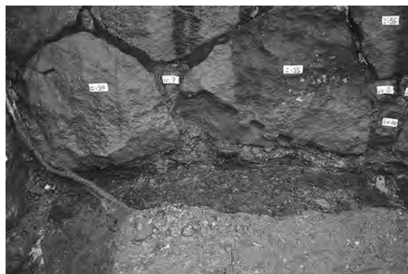
天守台石段上平場石垣根石に残る矢穴 (北から)
