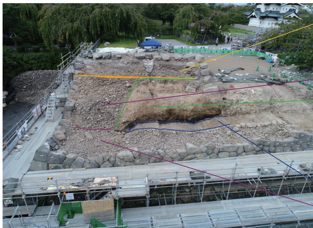
写真 1 天守台解体状況(東から)
