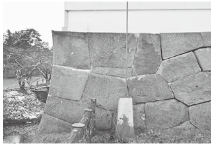
天守台北面 左出角部
