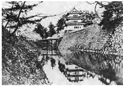
天守および東面石垣(修理完了後) 大正5年春 山上1980
