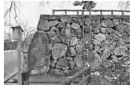
本丸南面 左方出角部周辺
