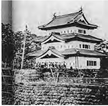
天守の曳屋状況 大正4年 山上1980
