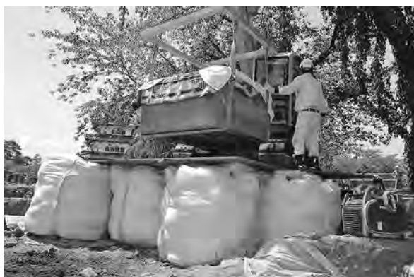
井戸枠移設作業風景(北から)
