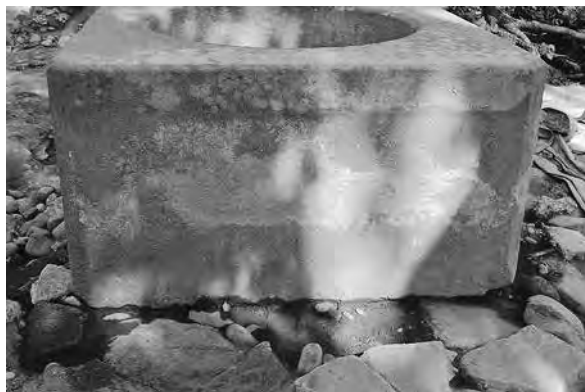
井戸枠西面(西から)
