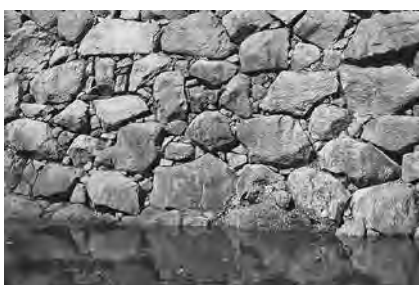
本丸南面 平石部の基部の石積み状況
