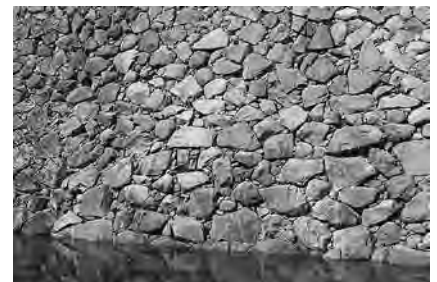
本丸南面 平石部の基部の石積み状況
