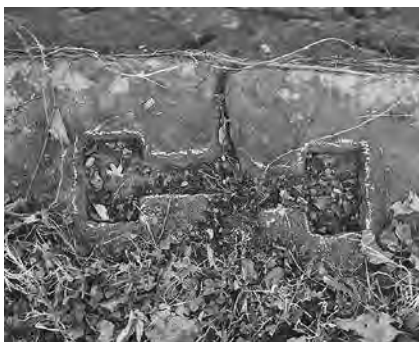
本丸東面 天端石上面に残る千切穴
