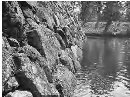
本丸南面 右方出角部の基部の迫り出し状況
