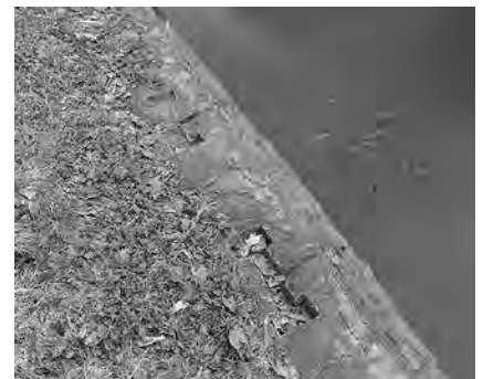
本丸東面 天端石上面に残る千切穴
