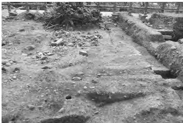
13グリッド井戸枠下の掘り込み・溝跡検出（西から）
