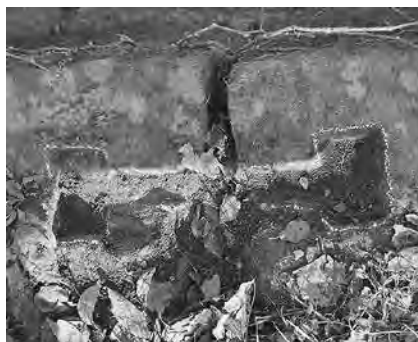
本丸東面 天端石上面に残る千切穴
