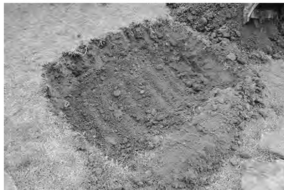
サツキ②(鷹丘橋北側)掘削範囲全景(東側)南西から
