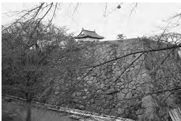
天守曳屋終了後(南から)11月18日
