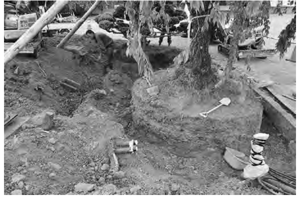
ヤエベニシダレ移植作業風景(西から)
