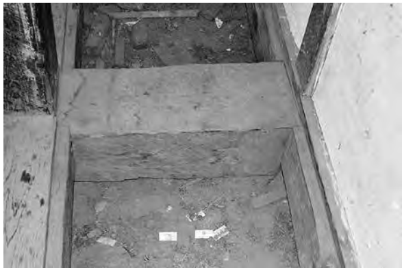
B区東側コンクリート敷設範囲（清掃前）南から
