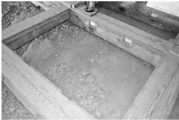
I区全景（南西から）
