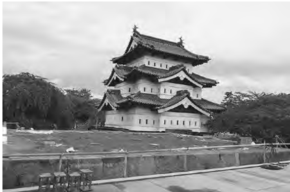
天守曳屋後の天守台全景 (上面に砂敷設済) 南東から
