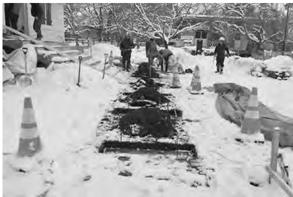
木柵基礎部分掘削（仮天守台西側）北から 1月12日
