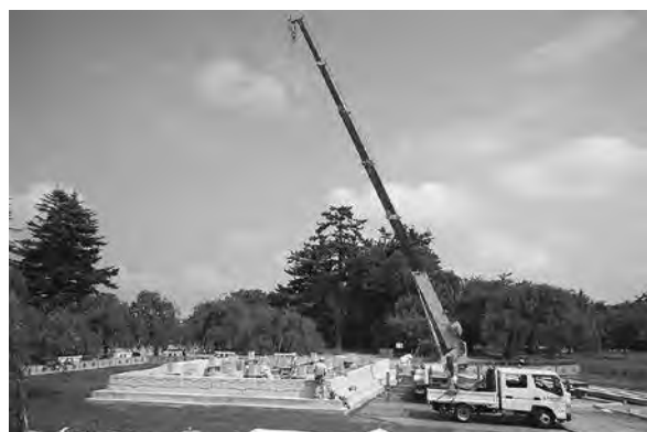
仮天守台設置工事(南から)8月7日
