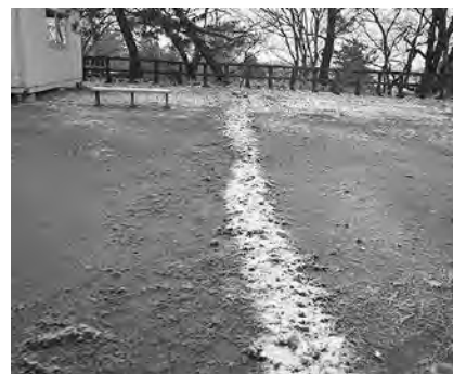
電線埋設完了(東から)
