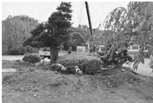
サツキD根鉢掘削作業風景（西から）
