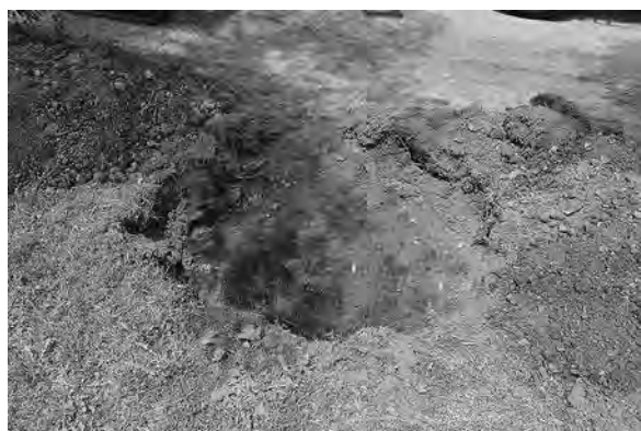
本丸東側芝生内サツキ移植先掘削範囲全景（北東から）
