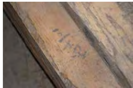
天守南東隅床梁墨書「三十四」(北から)
