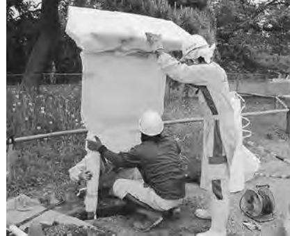
「本丸御殿御玄関礎石」解説看板撤去作業風景（北西から）
