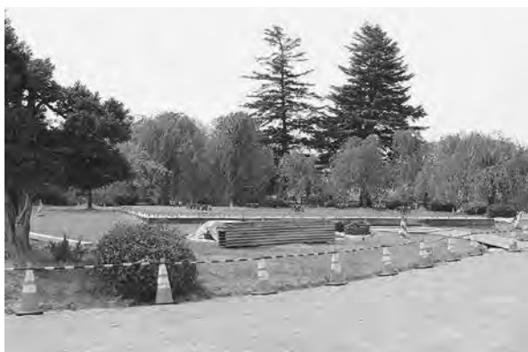
仮天守台設置工事(南東から)6月8日
