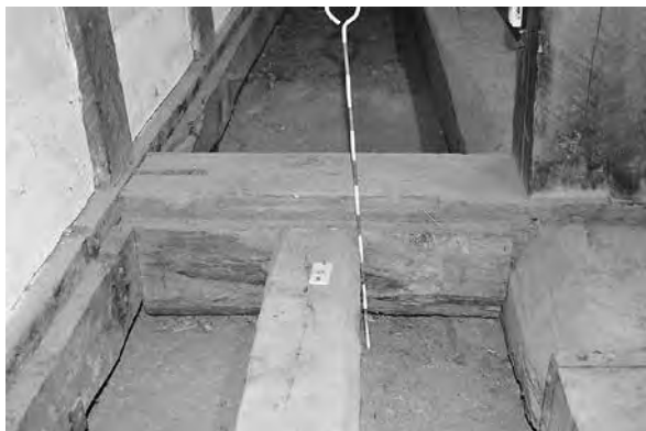
A区北側のコンクリート敷設範囲（西から）
