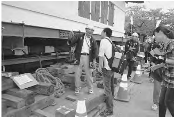
「曳屋ウィーク」での工事解説
