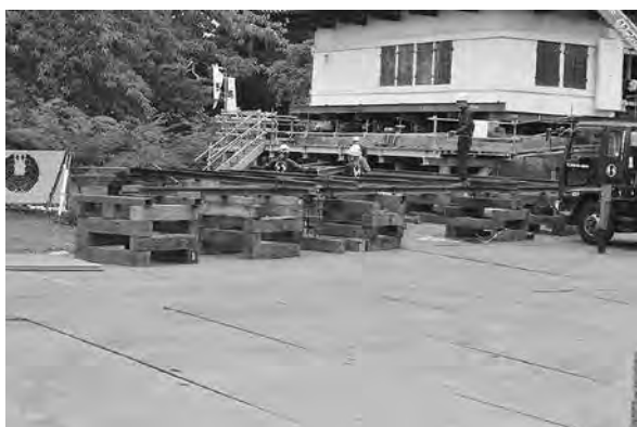
一次移動道設置(北西から)8月27日
