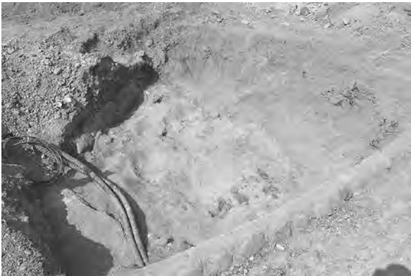
ヤエベニシダレ移植に伴う掘削範囲全景(南西から)
