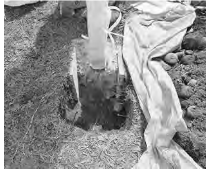
「弘前城史料館」看板脚部根本の掘削（西から）
