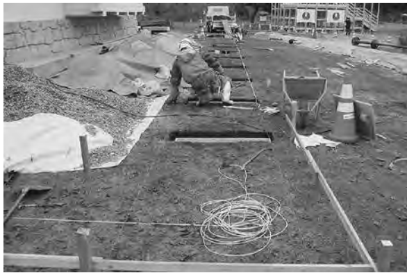
木柵基礎部分掘削（仮天守台南側）西から 12月21日
