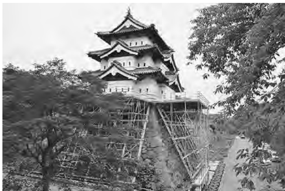
曳屋工事前足場設置(南から)6月17日
