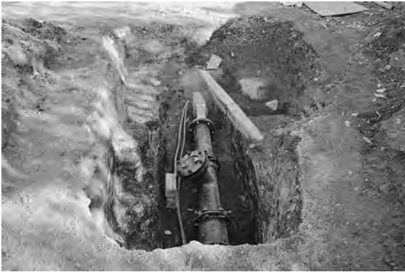
西側掘削範囲全景(西から)
