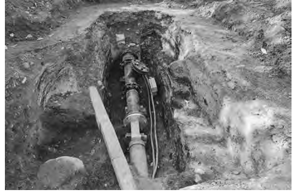
西側掘削範囲全景(東から)
