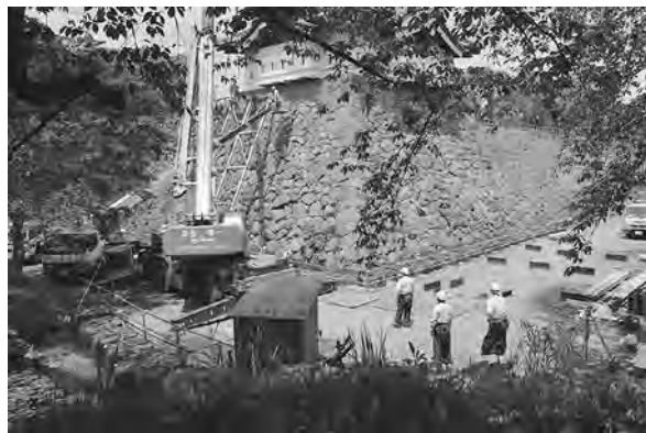
仮構台設置(南から)5月18日
