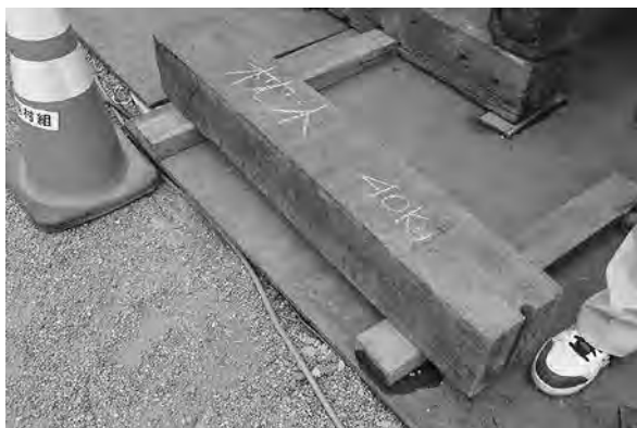
「曳屋ウィーク」での工事器材展示
