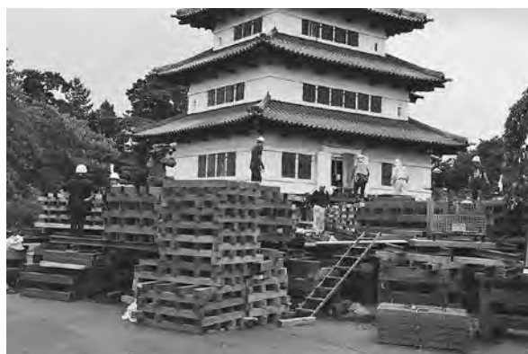
一次移動道設置(北西から)9月2日
