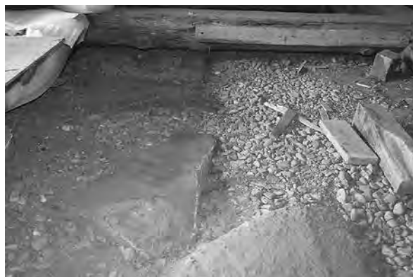
C区北側（南から）
