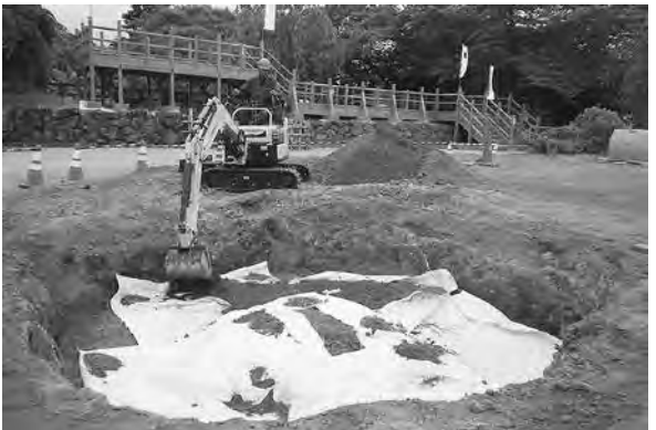
北側のいちい掘削範囲埋め戻し(北東から)
