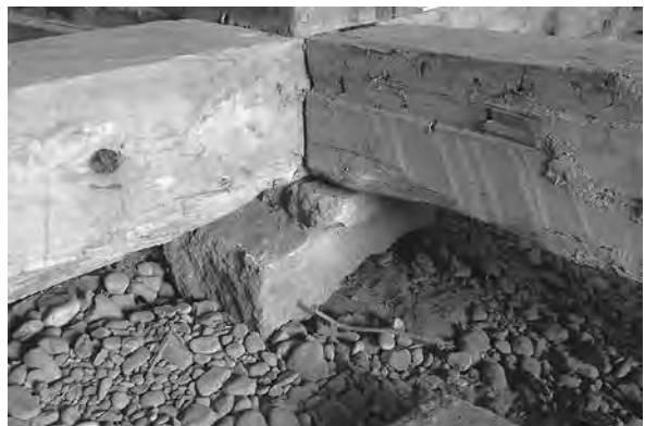
C区南東隅 天守台と床梁の間に入る石材（北西から）
