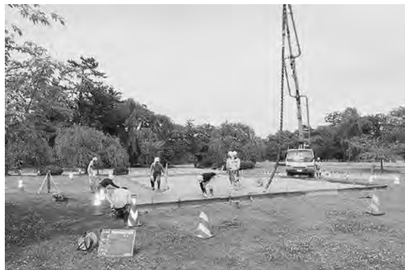
仮天守台設置工事(南から)6月5日
