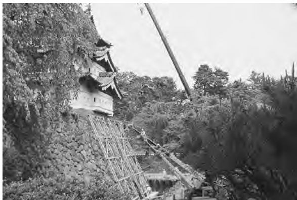
仮構台設置(西から)5月18日
