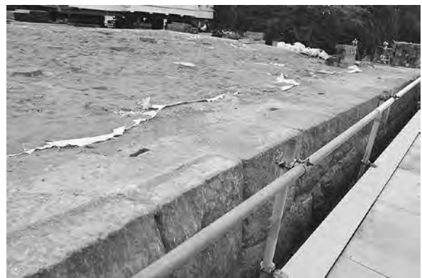
天守台石垣東側天端石 (南東から)
