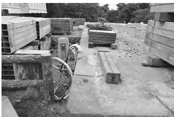
天守台石垣西側天端石 (南から)
