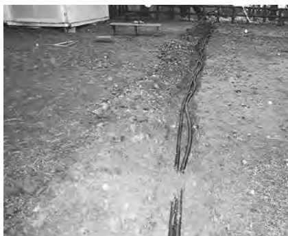
掘削区全景(東から)
