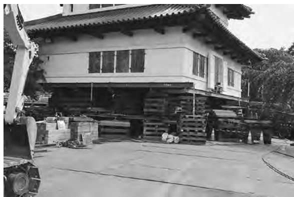
天守ジャッキダウン準備(北から)9月7日
