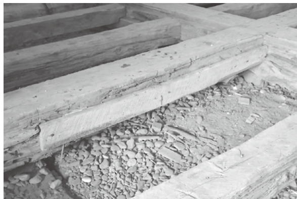
床梁に取り付けられた補修木材（C区北側床梁） 南西から
