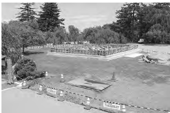
仮天守台設置工事(南東から)7月3日
