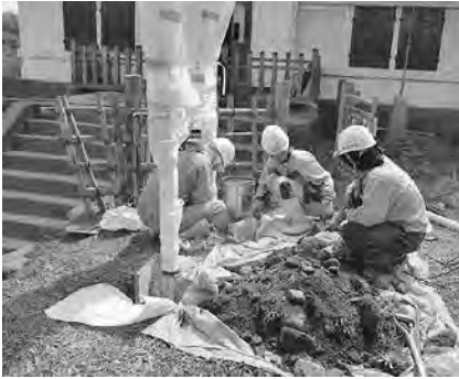
「弘前城史料館」看板撤去作業風景（西から）
