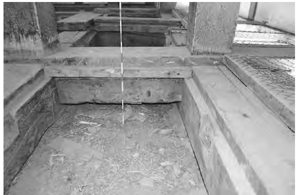
F区南側コンクリート敷設範囲（清掃前）西から
