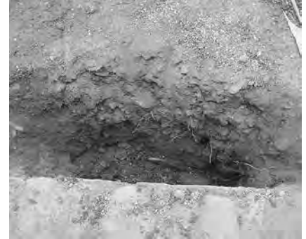
「本丸御殿御玄関礎石」解説看板脚部根本の掘削（東から）
