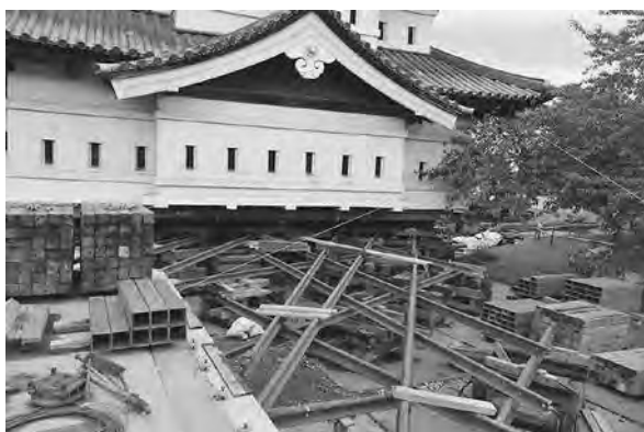
天守ジャッキダウン後(南東から)9月10日
