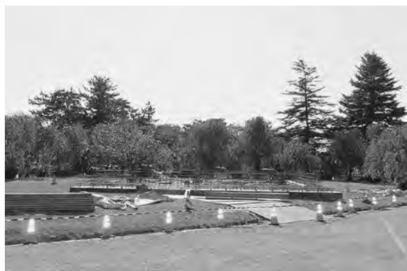
仮天守台設置工事(東から)6月10日
