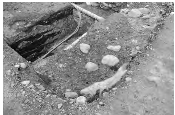
石垣発掘調査区B2南西隅 近代盛土と盛土③(南西から)
