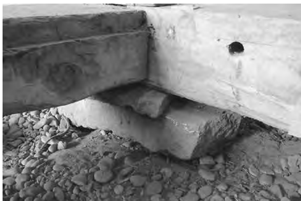
F区北東隅 天守台と床梁の間に入る石材（南西から）
