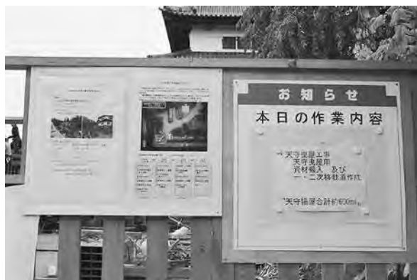
曳屋工事期間中の情報公開
