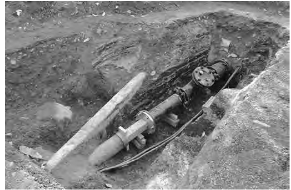
西側掘削範囲南壁土層断面(北東から)
