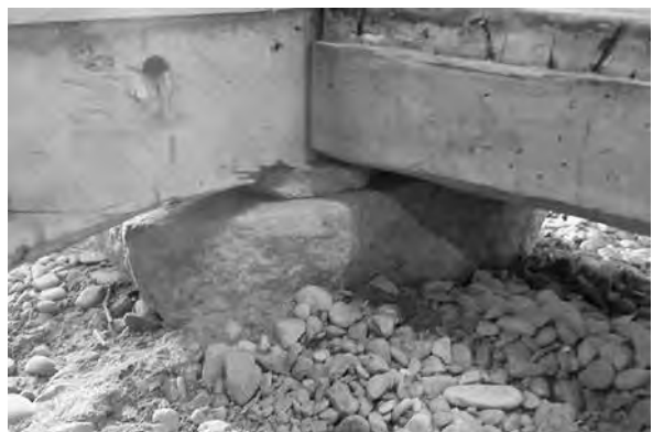
G区北西隅 天守台と床梁の間に入る石材（南東から）
