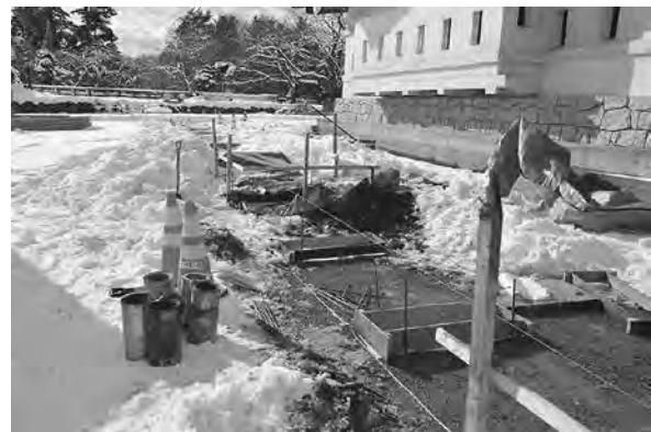
木柵基礎部分掘削（仮天守台東側）北から
