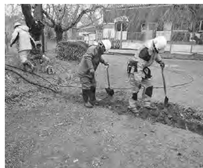
掘削作業風景(北から)
