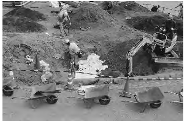
ヤエベニシダレ移植に伴う掘削範囲埋め戻し(南から)
