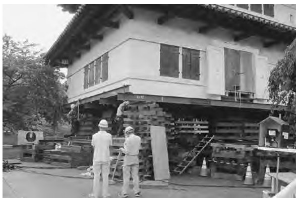
天守ジャッキダウン準備(西から)9月6日
