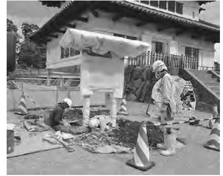
「弘前城天守」解説看板撤去作業風景（北西から）
