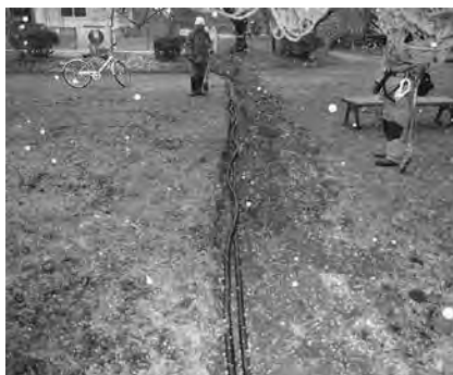
掘削区全景(西から)
