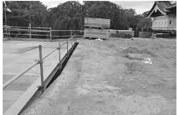
天守台石垣南側天端石 (東から)
