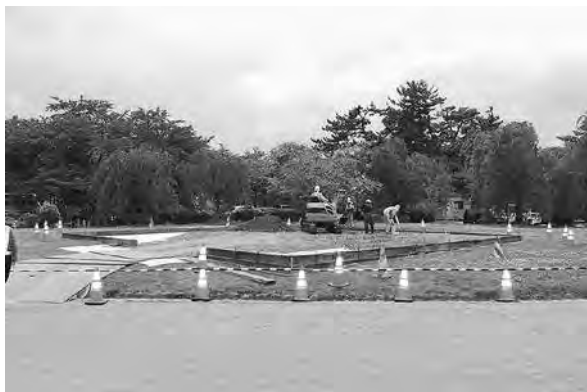
仮天守台設置工事(東から)6月4日
