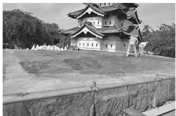
天守台表面保護作業風景 (南東から)
