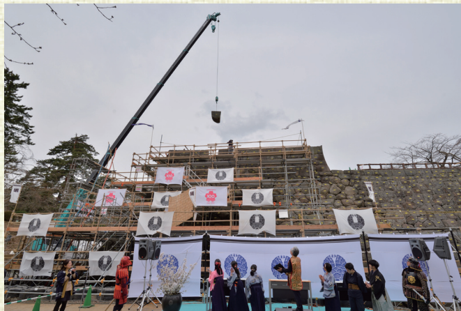
▲石垣解体始め式
