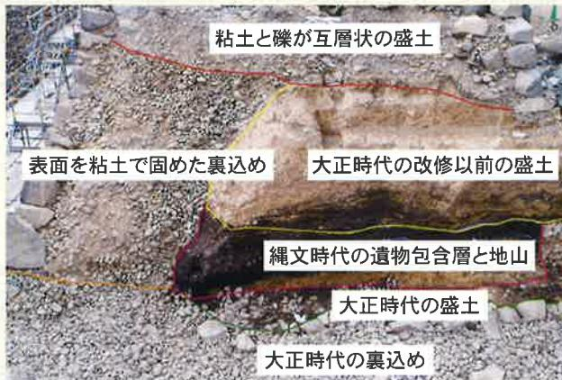
天守台下部の石垣は、大正時代の改修で築かれた石垣とそれ以前までに築かれた石垣と構成されています。改修以前の石垣は、縄文時代の土器を含む土層の上に、石垣を築くために掘削した粘土や土を盛土し、その前面に築石と裏込めを積み上げて築かれています。また、天守台天端付近の石垣は下部の石垣と構造が異なっており、盛土は粘土と礫（小石などのこと）を互層状に突き固め、築石にはチキリやダボという接合具を多く用いて、接する築石同士をつなぎ止めて固定する工夫が施されていました。一方、大正時代の改修で築かれた石垣は、改修前の盛土の上に新しい盛土が盛られ、その盛土と新しい裏込めの境には比較的大きな石が階段状に積み上げられていました。また、明治時代の石垣崩落面の裏込め部分には、崩落防止の粘土が貼り付けられており、大正時代の改修時にも崩落防止の工夫が施されていたことがうかがえました。
