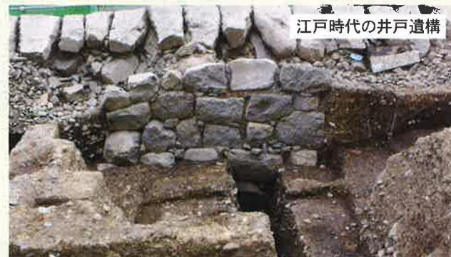
排水遺構は、井戸などからの排水を石組の暗渠（あんきょ）を通して蛇口から内濠へ流すための施設です。暗渠には水漏れ防止のために粘土を充填していましたが、経年劣化により水が漏れ、周辺の地盤が浸食されていました。このような地盤の劣化も石垣の膨らみの原因の一因と考えられます。
