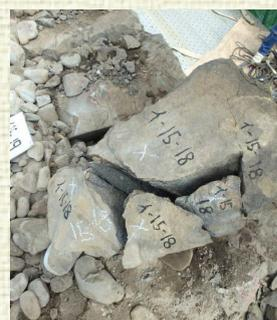
▲破損が著しく補修できない築石（※4）
