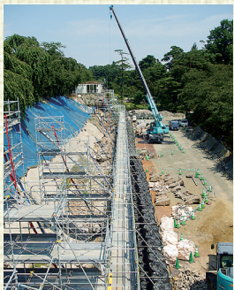
▲積み直しが進む北側工区(令和3年8月)(※1)
