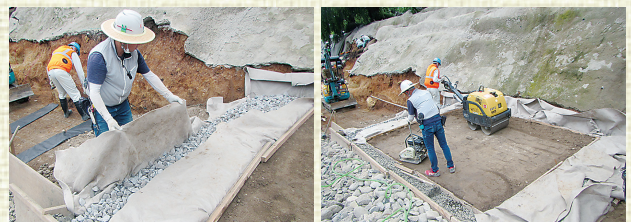
▲湧き水対策設置状況（暗渠〈あんきょ〉排水）（※3）
