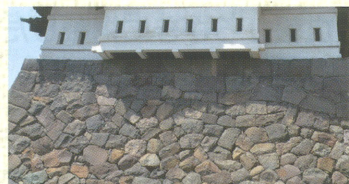
▲（※4）天守台石垣東面の谷落とし積
