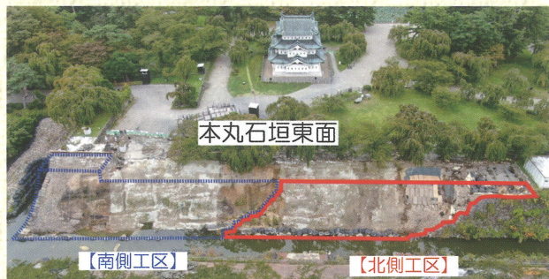
▲（※2）石垣積み直し工事の工区分け
