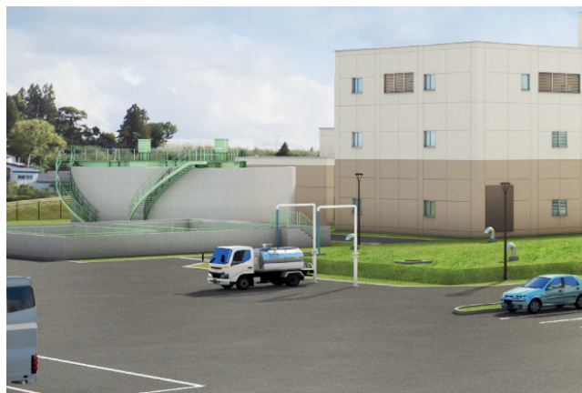
新樋の口浄水場における応急給水方法
