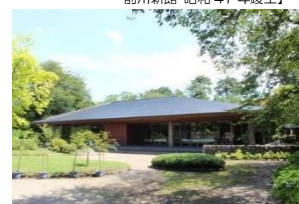
【弘前市緑の相談所 昭和55年竣工】
