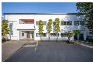
【木村産業研究所 昭和7年竣工】
